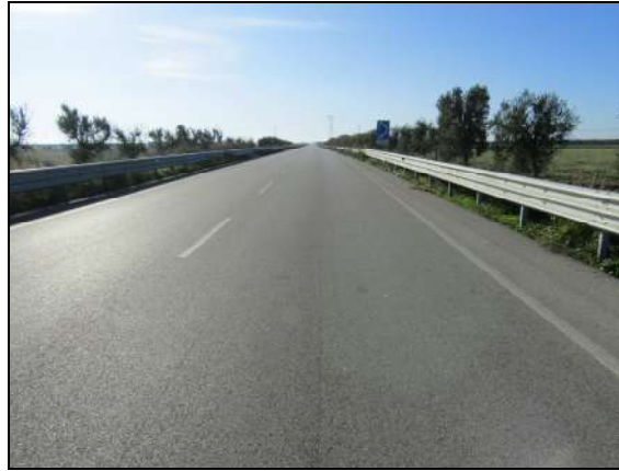
4. Elettrodotta lungo la SP 77, località Mass. Dell'Erba
