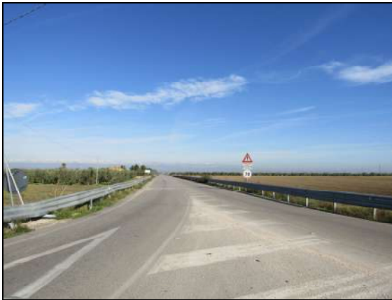
5. Elettrodotta lungo la SP 77, località Podere n°774
