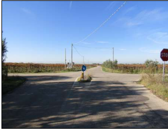
8. Elettrodotto lungo la SP 88, da SP 69 in direzione dell'A 14, località Podere n°228
