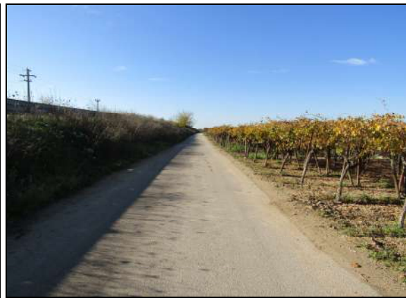
11. Elettrodotto lungo la strada di servizio parallela all'autostrada, località l'Olmo/Mass. Colangelo
