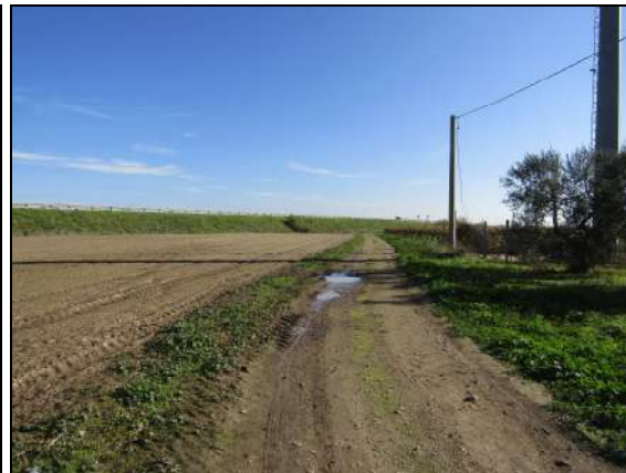
13. Elettrodotta dal parco fotovoltaico in direzione della A 14, località C. Napolitano
