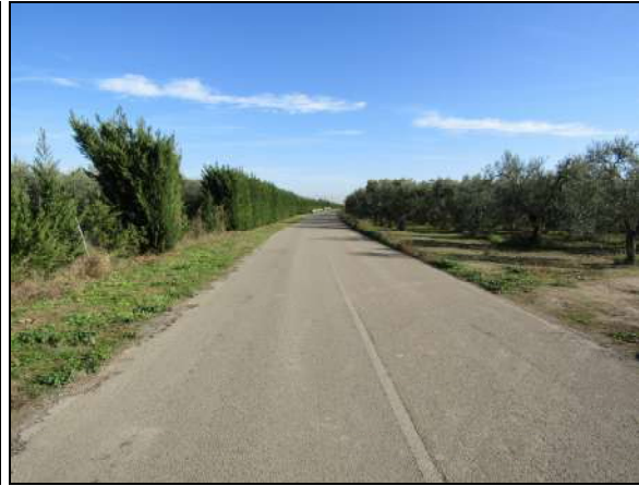
9. Elettrodotto lungo la SP 88, località Mass. Acquarulo di Grillo
