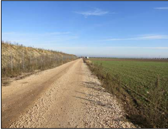
3. Elettrodotta dall'area di installazione della stazione elettrica in direzione della SP 77, località Mass. Paletta
