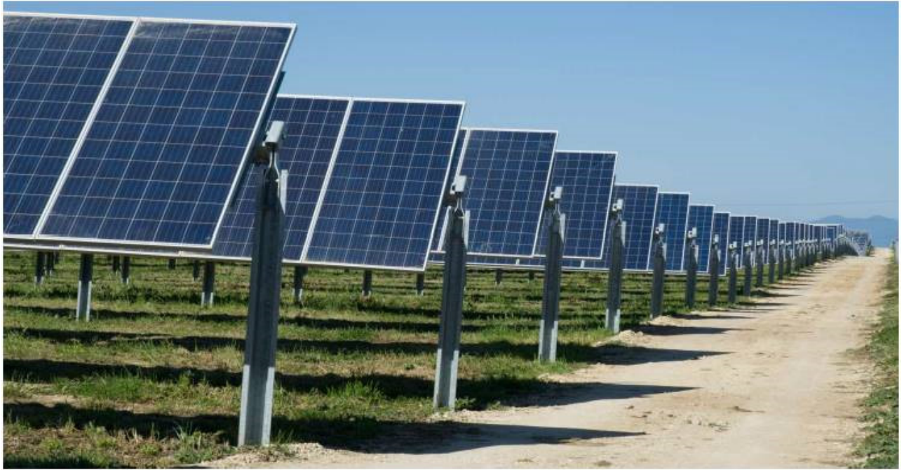
Figura 2: Struttura mobile ad inseguitore solare portamoduli TRACKER
