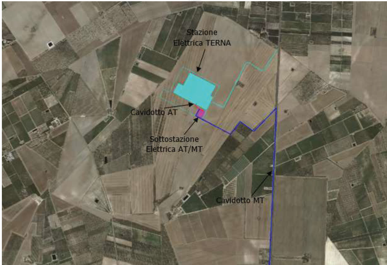
Figura 2: Inquadramento su ortofoto dell'area occupata dalla Sottostazione Elettrica AT/MT
