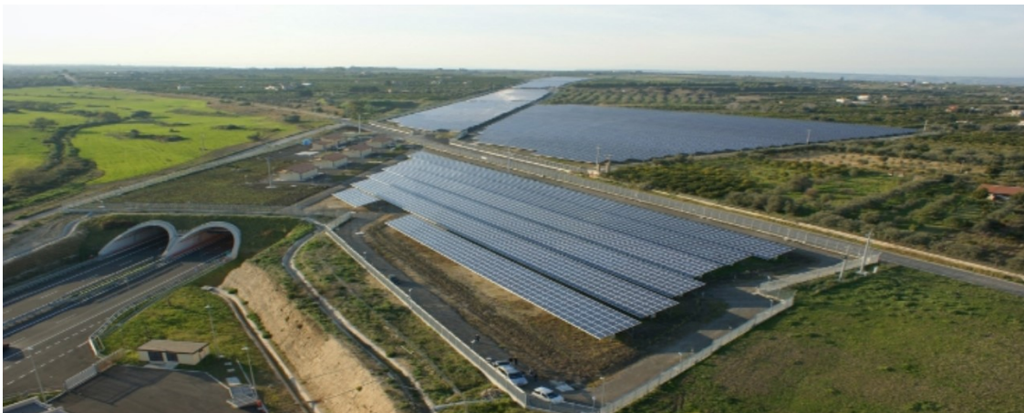
Figura 3: Impianto fotovoltaico a terra ubicato al di sopra delle gallerie artificiali dell'Autostrada Catania-Siracusa
