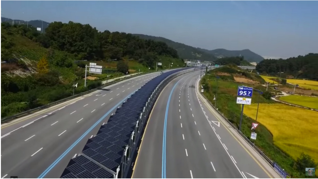
Figura 5: Pista ciclabile alimentata ad energia solare costruita al centro dell'autostrada che collega Daejeon e Sejong
