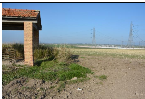
Fig. 14 Fg107, part. 47. Il terreno, la sottostazione
