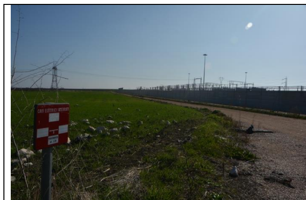
Fig. 11 Fg126, part. 52. Il cavidotto e la sottostazione
