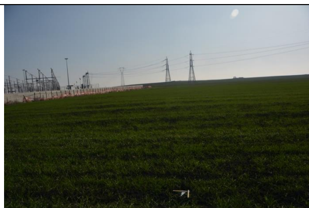
Fig. 12 Fg107, part. 47. Il terreno e la sottostazione
