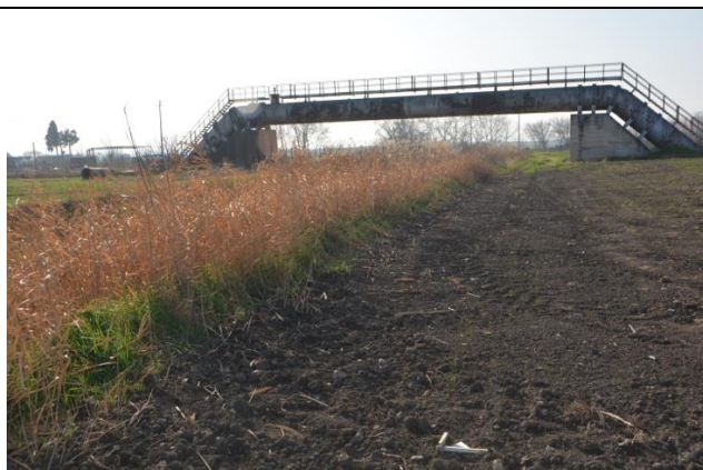
Fig. 17 Fg107/126, part. 460/417. La e condotta idrica
