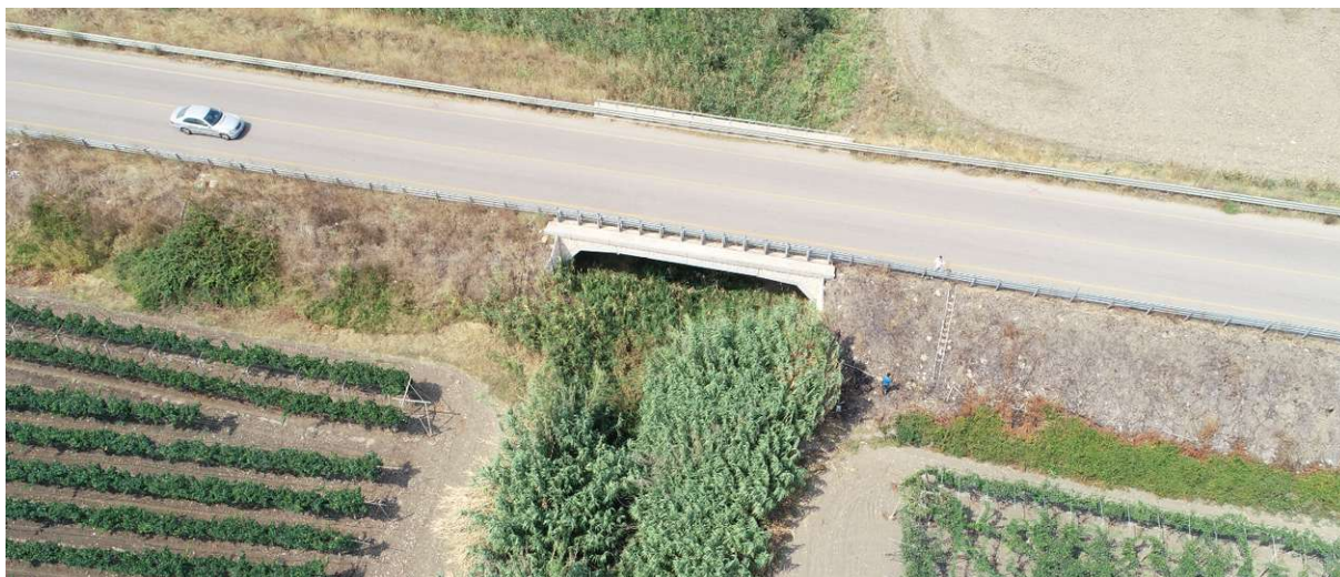
Fig. 20: Foto di uno degli attraversamenti rilevati scattata durante il rilievo mediante l'ausilio di un drone
