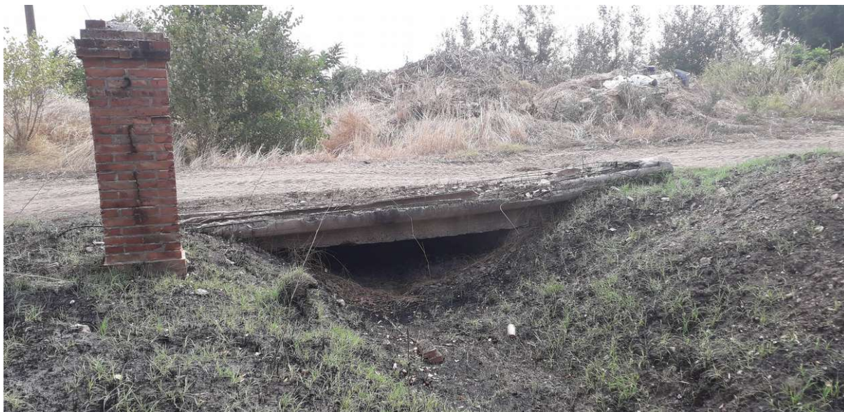
Fig. 18: Foto attraversamento scattata da monte verso valle
