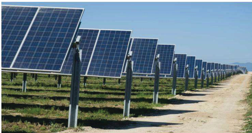
Figura 3: Struttura mobile ad inseguire solare portamoduli TRACKER
