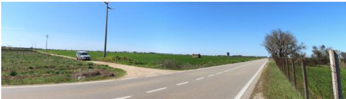
Figura 4 – vista dell'area di impianto (campo 2) dallo spigolo sud est della SP18
