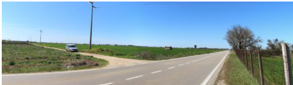
Foto 2 – vista dell'area di impianto (campo 2) si evidenzia la giacitura piana e la presenza di elementi antropici
