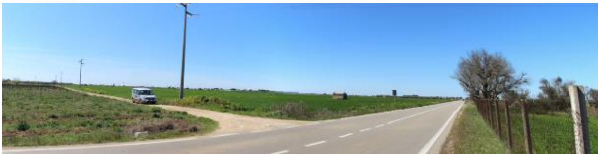
Figura 6 - vista dell'area di impianto (campo 2) dallo spigolo sud est della SP18
