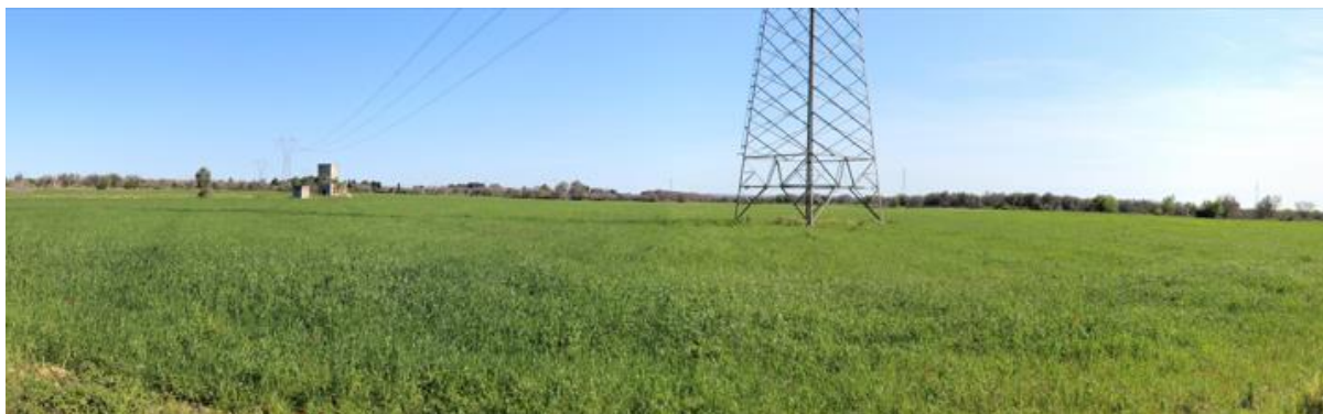
Figura 13 - vista dell'area di ubicazione della futura stazione Terna "Galatina" RTN 380/150 kV
