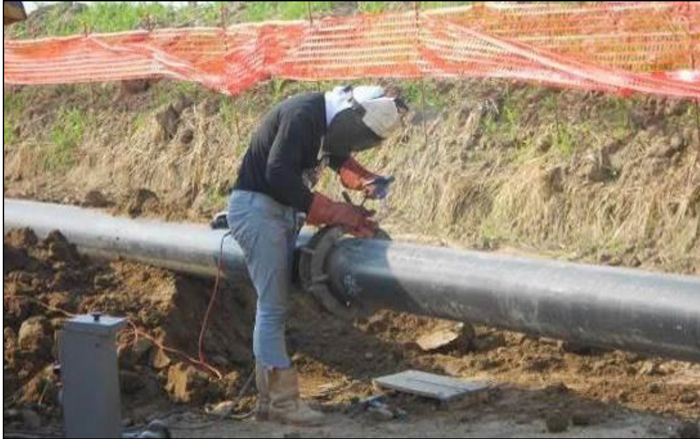
Fig. 9.4/A: Saldatura della tubazione
