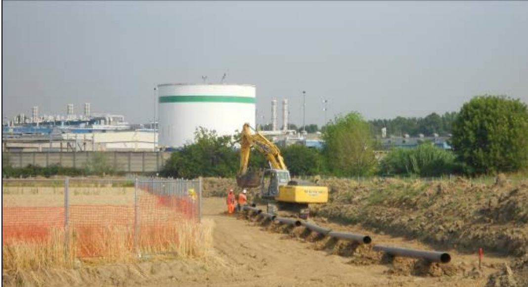
Fig. 9.3/A: Sfilamento tubi
