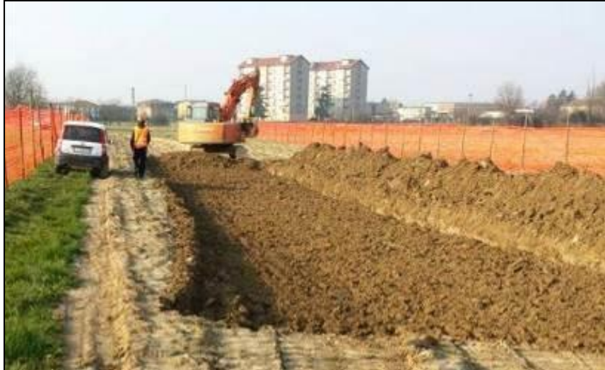
Fig. 9.2/A: Apertura della pista di lavoro
