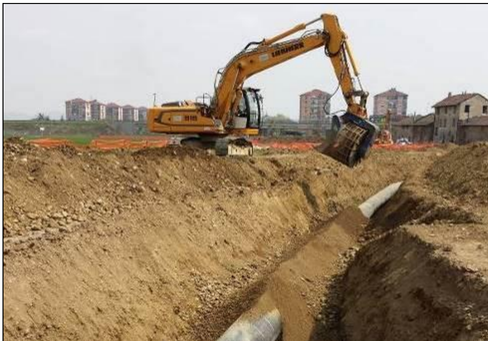
Fig. 9.9/A: Rinterro della condotta
