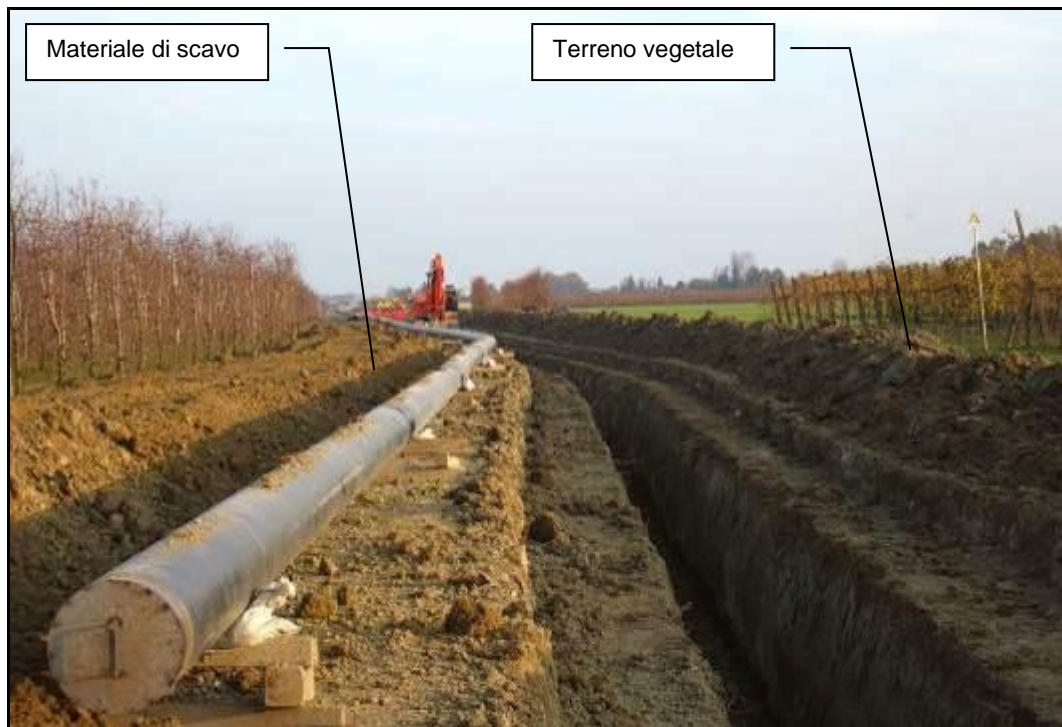
Fig. 9.6/A: Scavo della trincea
