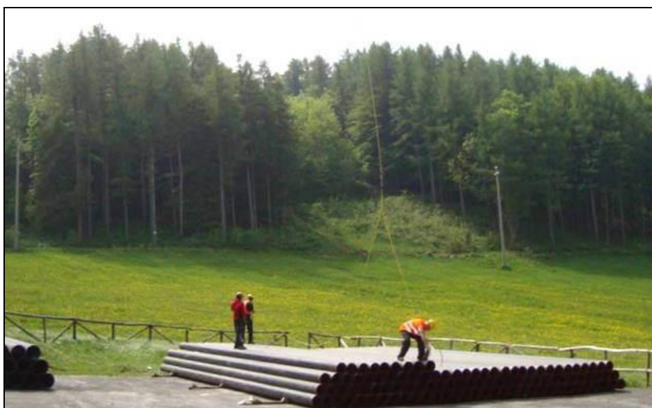
Fig. 9.1/A: Piazzola di accatastamento tubazioni
