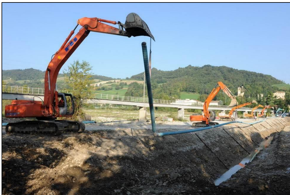
Fig. 9.8/A: Posa della condotta
