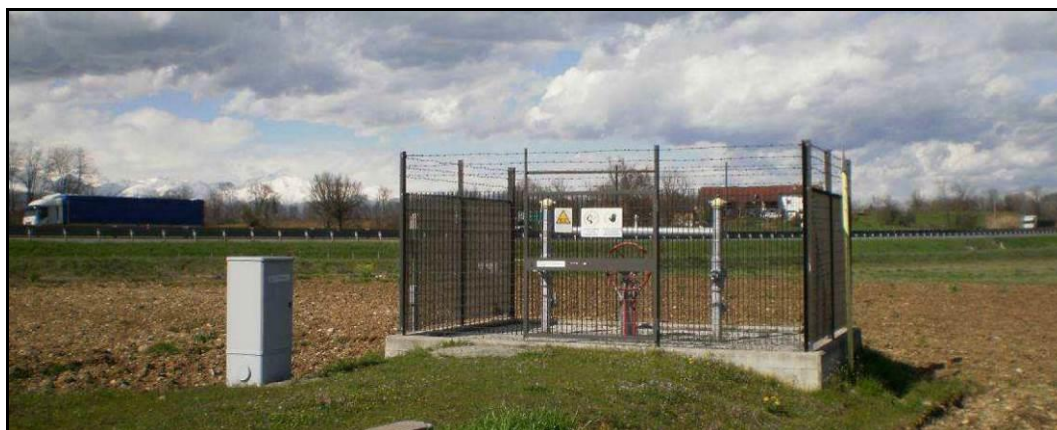
Figura 2.4/F – Esempio di impianto al termine dei lavori
