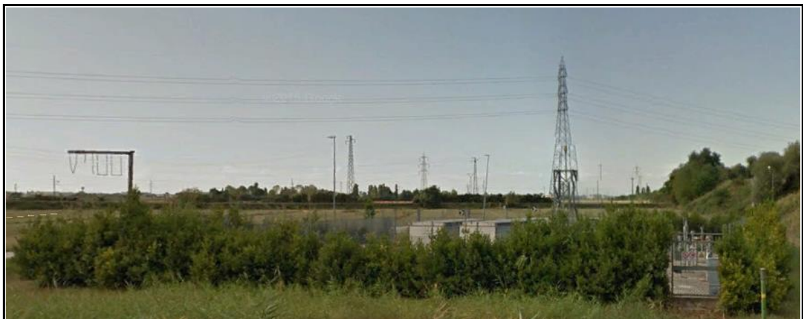
Foto n.6.4/B – Stesso impianto con fascia arbustiva di mascheramento ormai attecchita.
