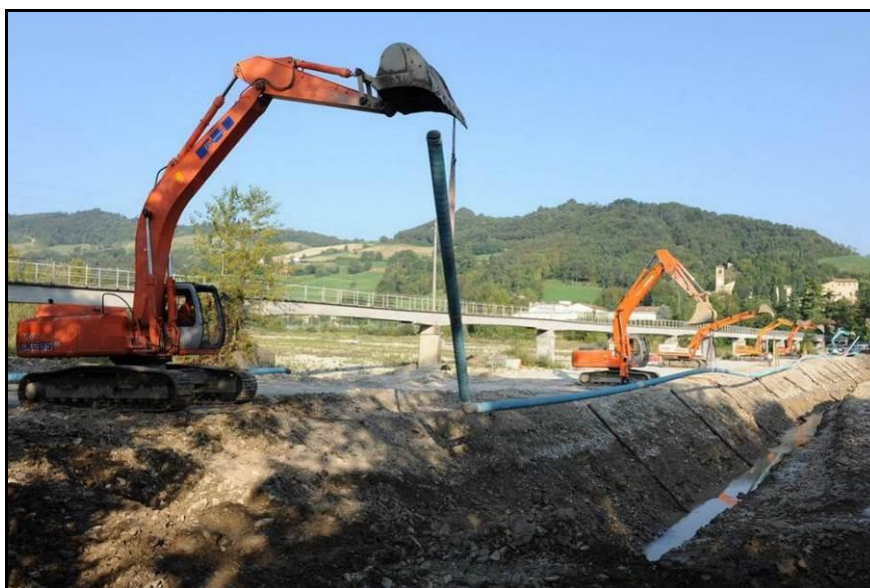
Figura 2.4/E - Posa della condotta
