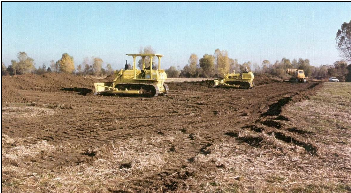
Figura 2.4/B - Apertura della pista di lavoro
