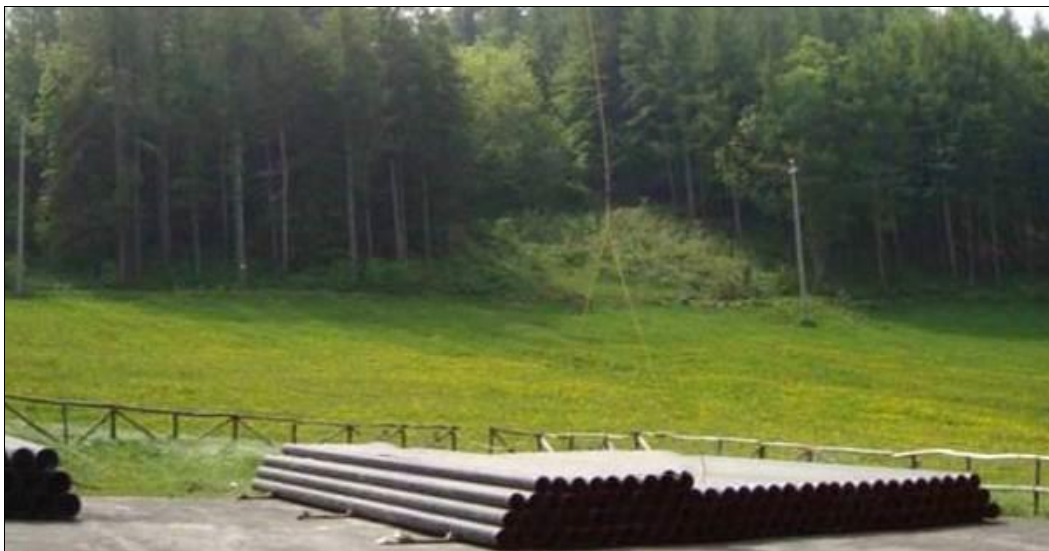
Foto 2.4/A - Piazzola di accatastamento tubazioni
