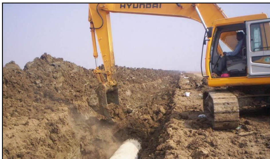
Figura 2.4/F - Rinterro della condotta
