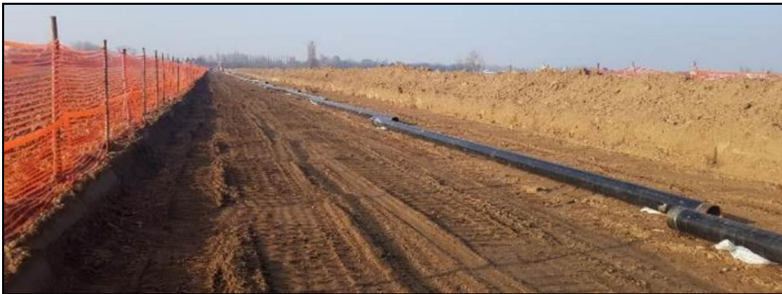
Foto 2.4/C – Sfilamento delle tubazioni di linea
