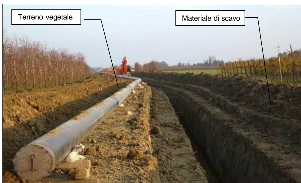
Figura 2.4/D - Scavo della trincea
