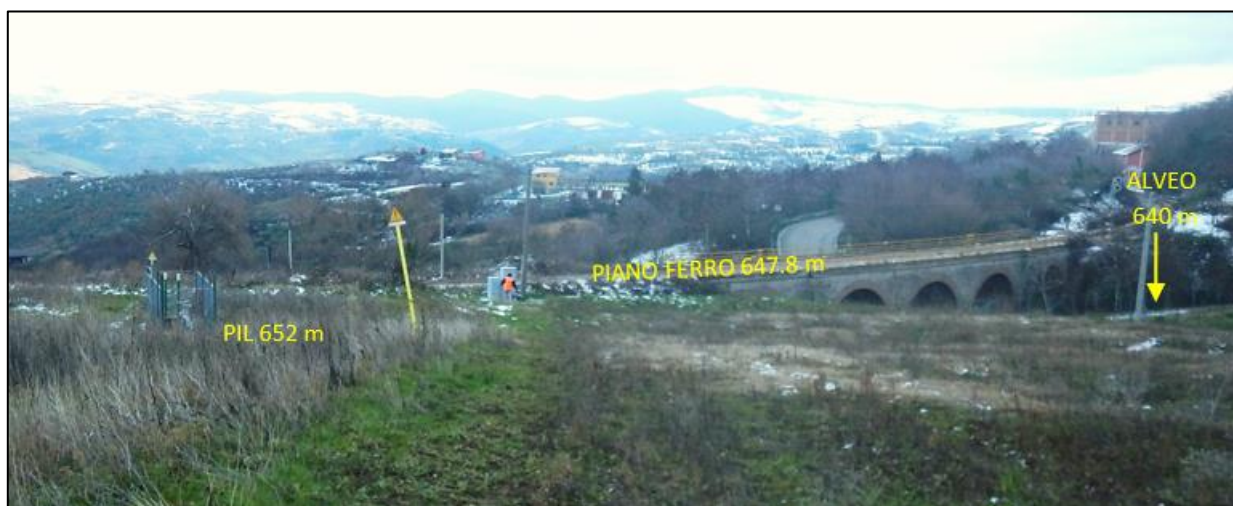
Figura 3.1/D – Immagine panoramica del pendio ove sorge l’impianto esistente da sostituire, con evidente il ponte della FS Foggia-Potenza
