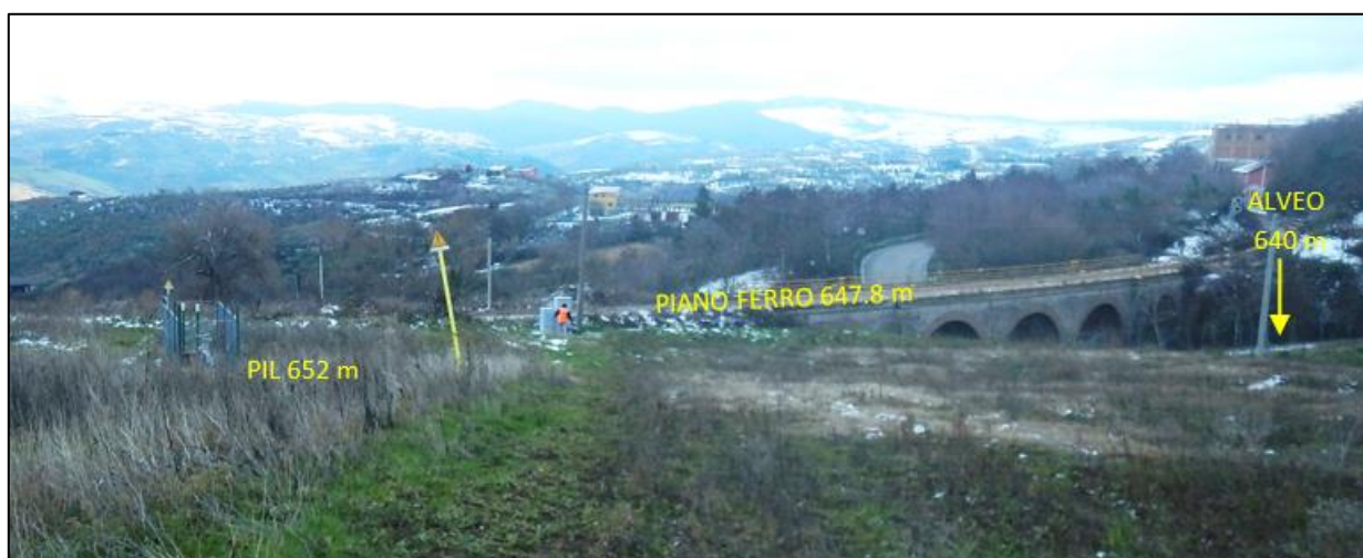
Figura 2.2/D – Fotografia dell'impianto esistente da sostituire
