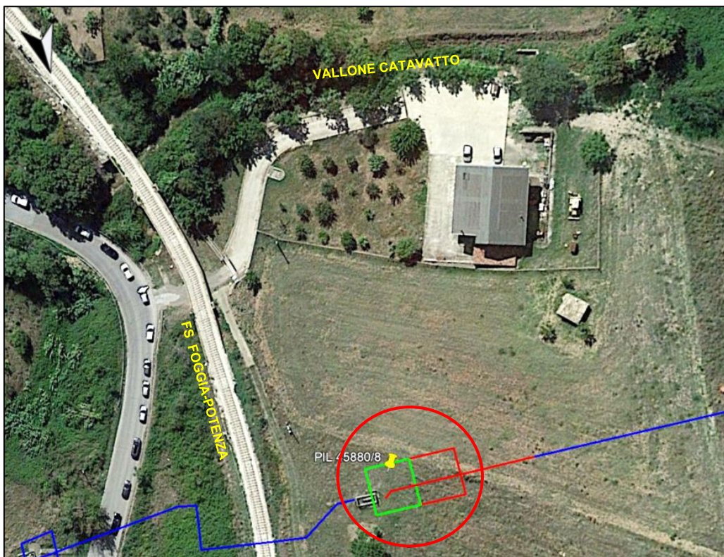
Figura 2.2/C – Vista aerea dell'impianto esistente da sostituire
