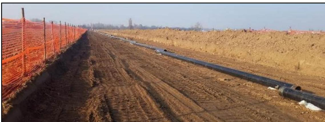
**Figura 3-3: Sfilamento delle tubazioni di linea**
