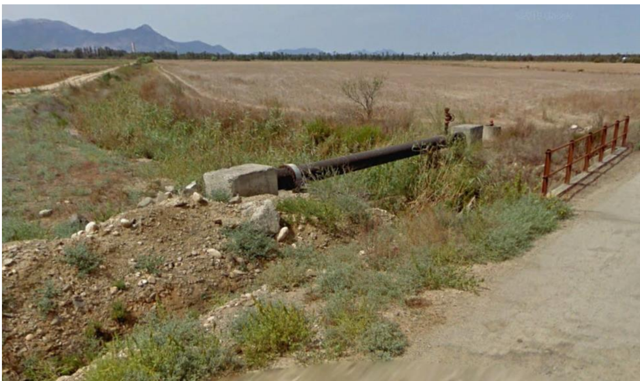
Figura 2: artificializzazione del Rio e condotte fuori terra
