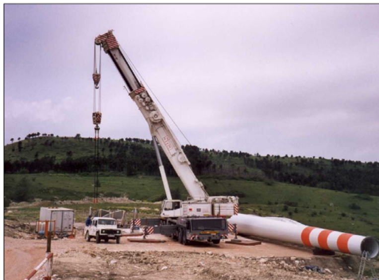
Figura 1.4.6.-1.: Fase di montaggio di un aerogeneratore.
