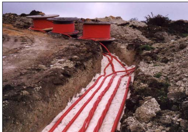
Figura 1.4.7.-1.: Particolare della posa cavi elettrici
