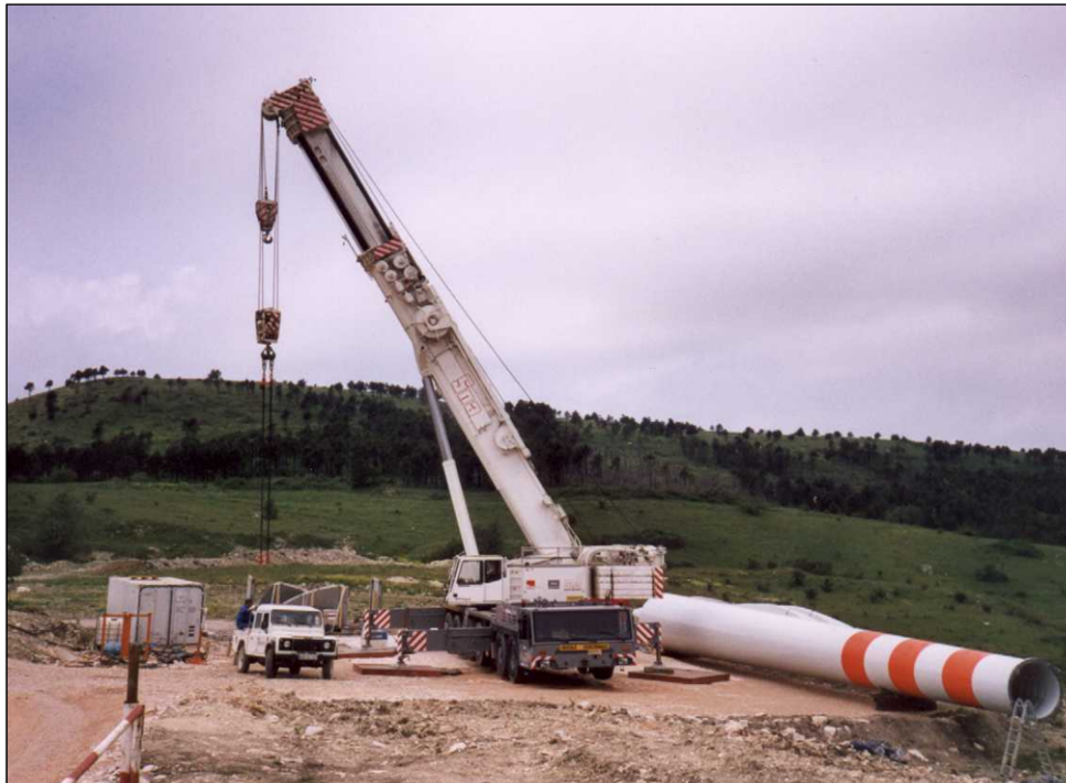
Figura 1.4.6.-1.: Fase di montaggio di un aerogeneratore.
