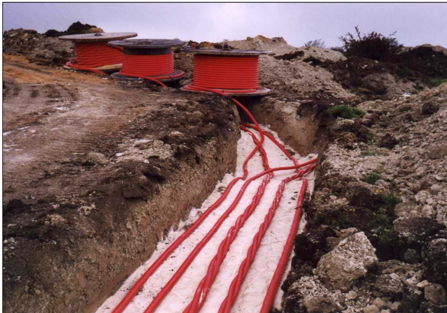
Figura 1.4.7.-1.: Particolare della posa cavi elettrici.
