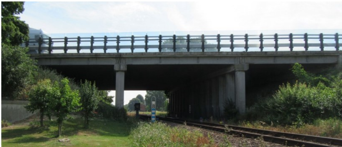
Stato attuale del sottopasso ferroviario - vista da ovest
