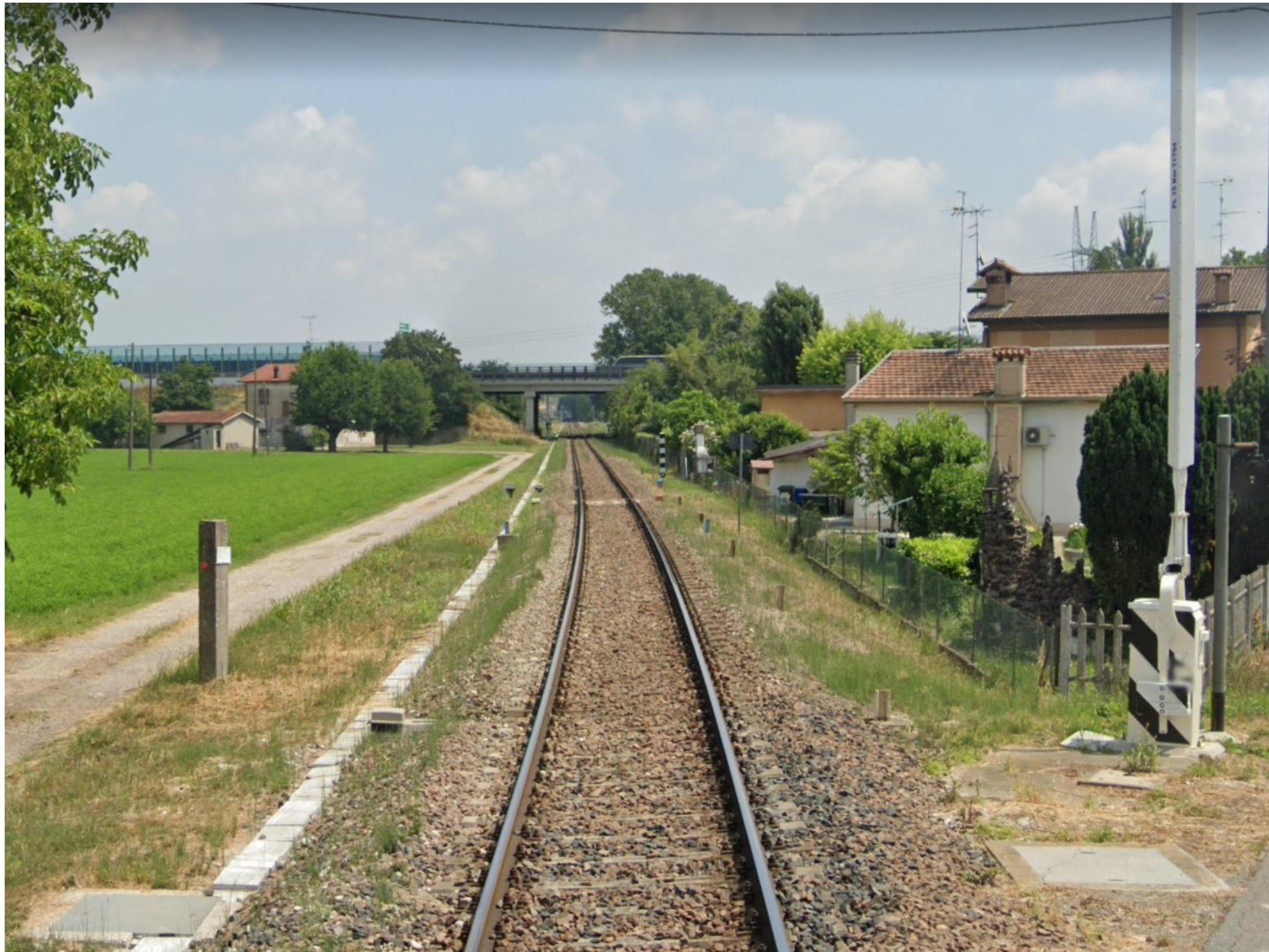
TAVOLA 4 - Veduta del sottopasso ferroviario Suzzara-Ferrara (km 275+618) vista da ovest (© 2023 Google Streetview)
