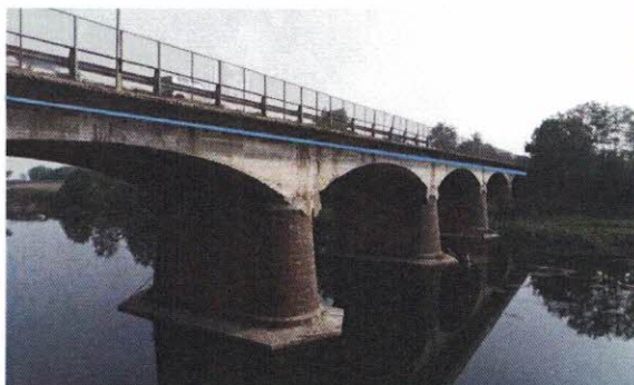
Figura 30. Strada Regionale 10-Attraversamento fiume - Posa linea elettrica su ponte
