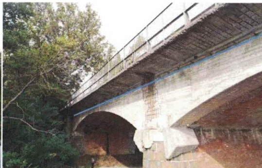
Figura 31. Strada Regionale 10-Attraversamento fiume - Posa linea elettrica su ponte
