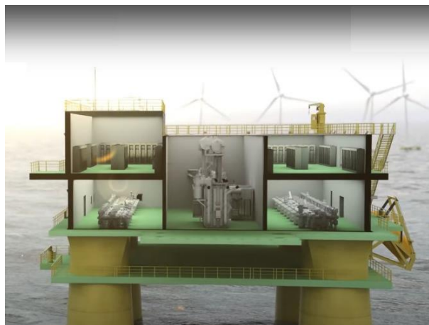
Figura 3-2: Esempio di OSS semisommersibile a pianta quadrata
