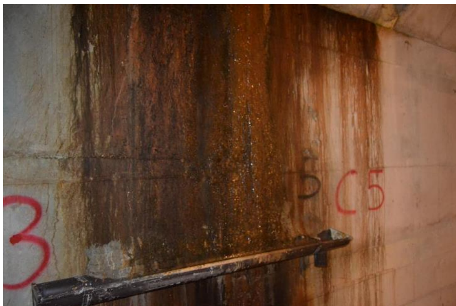
Figura 8 - Vista dall'interno del cunicolo del giunto 3-5
