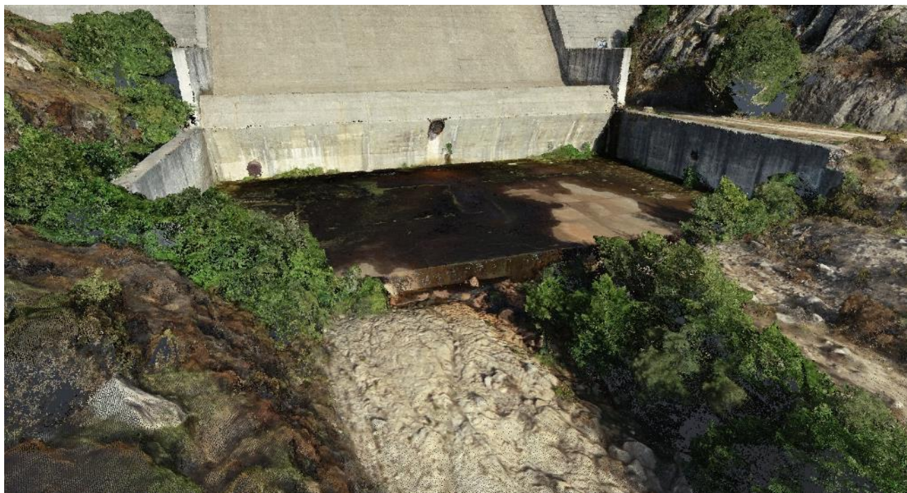
Figura 4 - Estratto nuvola di punti - Erosione alla base della platea
