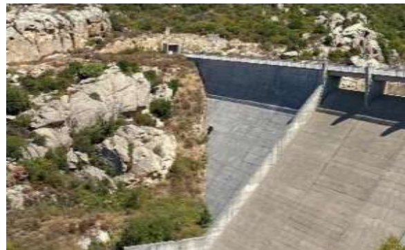
Figura 5-13 Vista ingresso cunicolo sponda Nord
