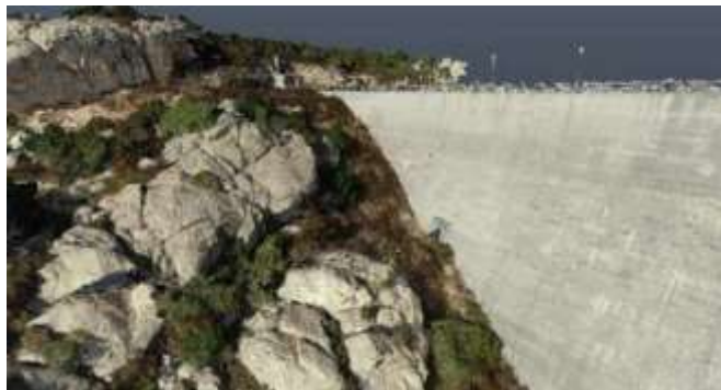
Figura 5-12 estratto dalla nuvola di punti, ingresso al cunicolo sulla sponda nord
