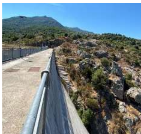
Figura 5-15 scala di accesso ai cunicoli lato Sud non terminata
