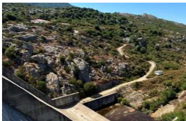
Figura 5-10 Viabilità interna, via di accesso al piede del rilevato ed ai cunicoli lato Sud
