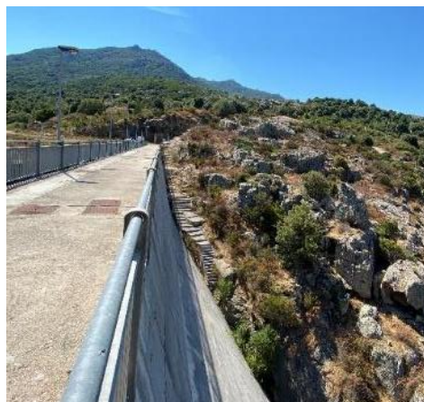
Figura 20 scala di accesso ai cunicoli lato Sud non terminata
