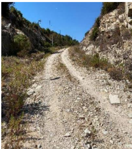
Figura 13 Pista di accesso al coronamento
