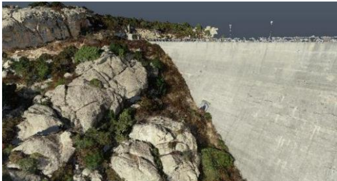
Figura 17 estratto dalla nuvola di punti, ingresso al cunicolo sulla sponda nord
