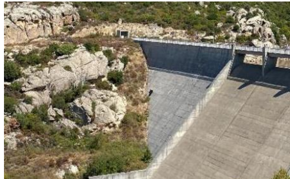
Figura 18 Vista ingresso cunicolo sponda Nord
