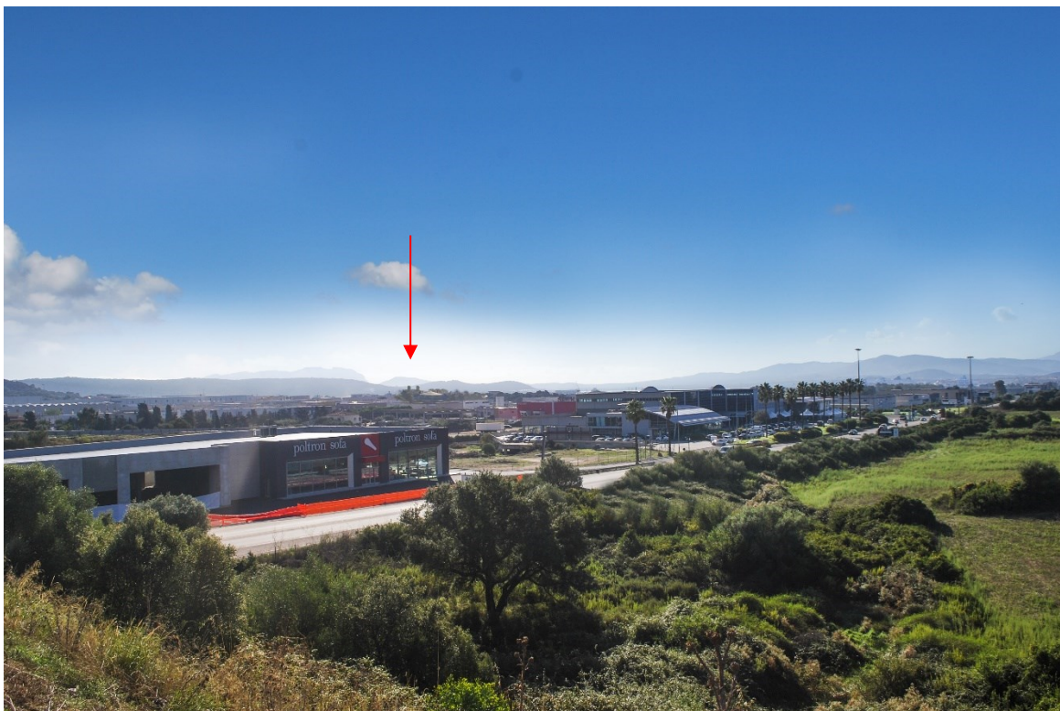
Figura IV.1 - Vista 1 ante e post operam
