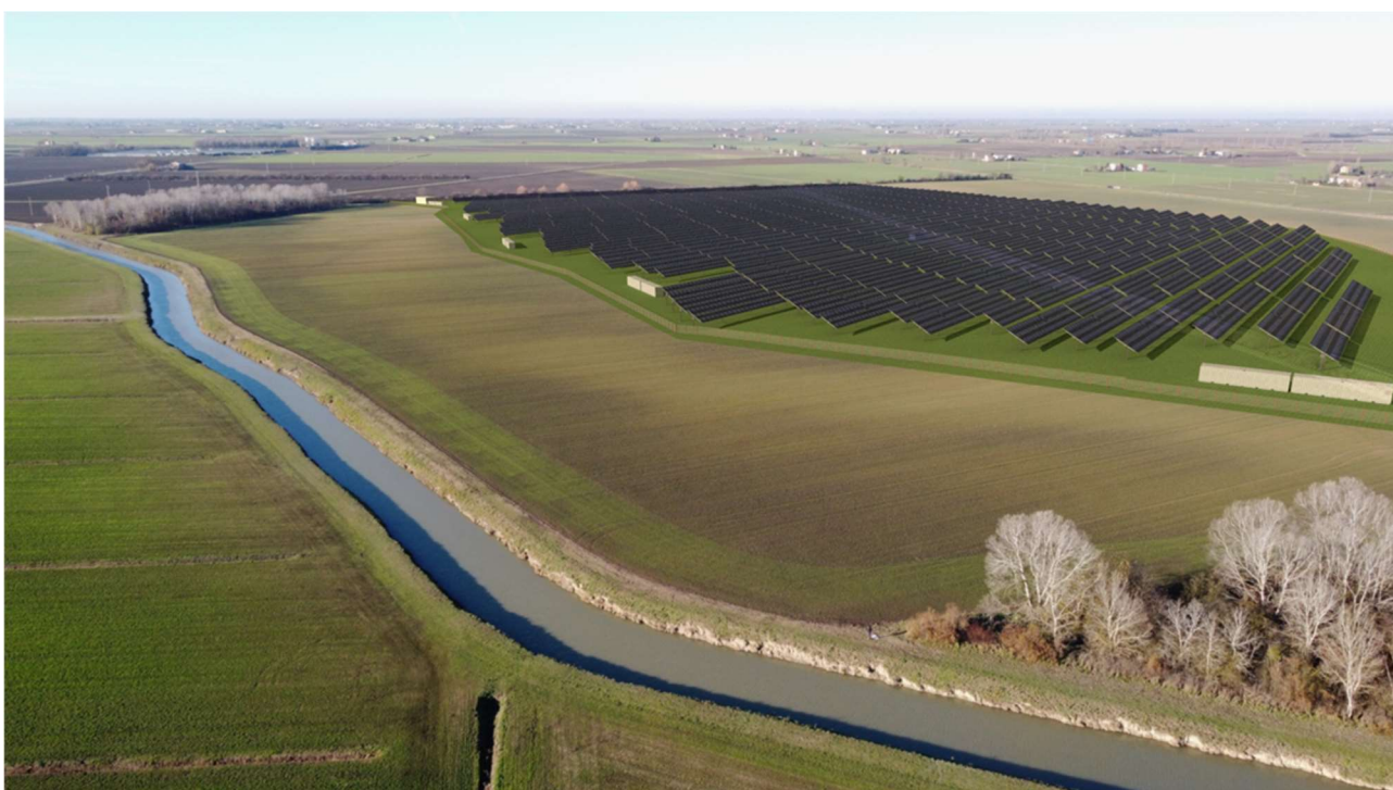
Figura 42 - Punto di osservazione 4 post-intervento
