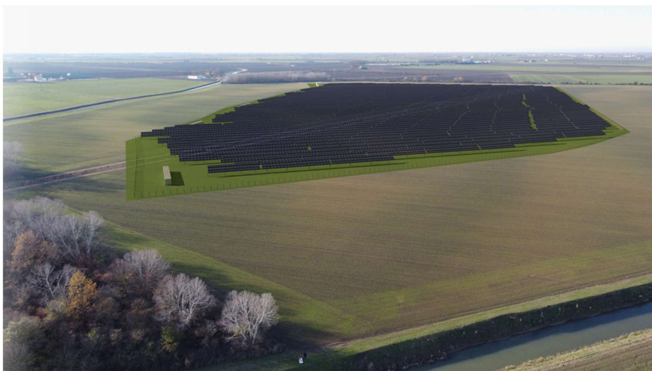
Figura 39 - Punto di osservazione 3 post-intervento
