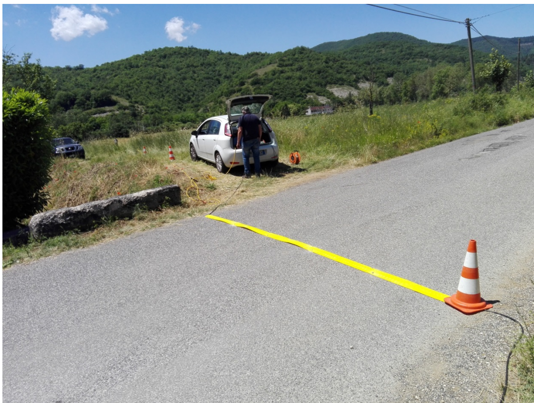
Attraversamento su S.P. n° 34
