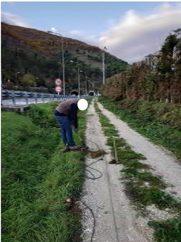
Energizzazione con mazza battente onde trasversali (Onde Sh)-(Profilo 2 sismica a rifrazione)
