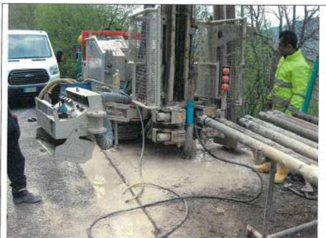
Istallazione piezometro in corrispondenza del sondaggio S1
