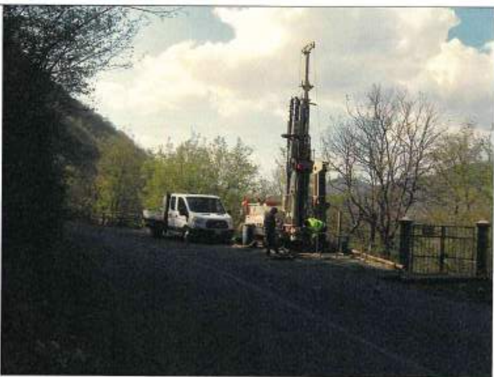
Esecuzione sondaggio S1
