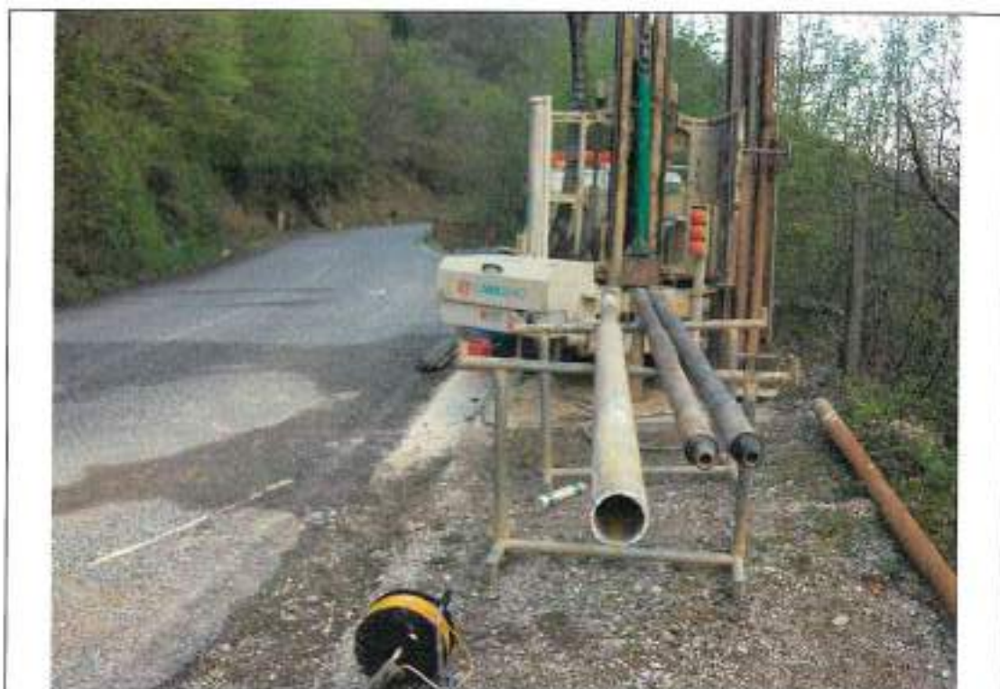
Esecuzione prova SPT in sondaggio n.1
