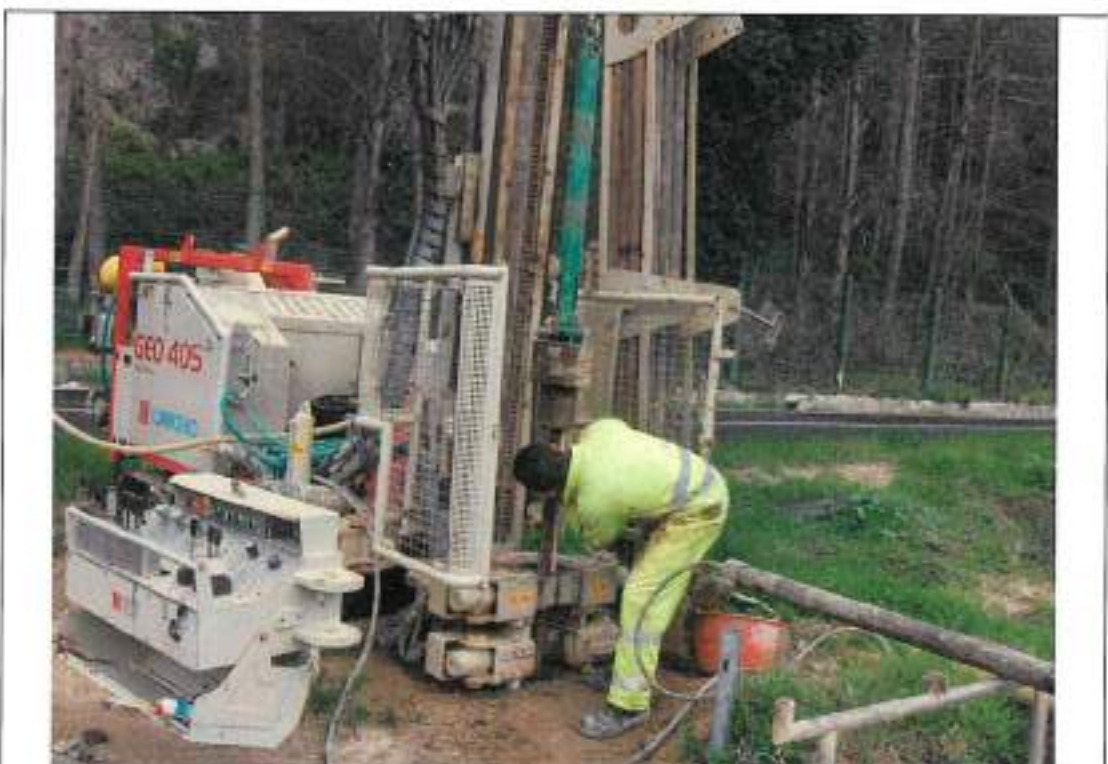
Esecuzione prova SPT in sondaggio n.3
