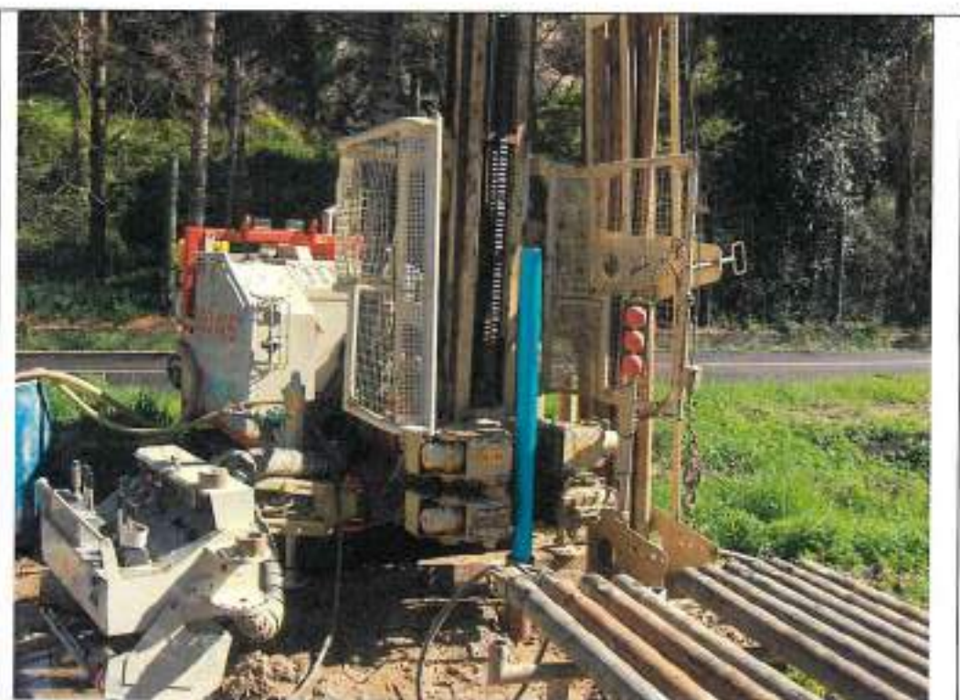
Istallazione piezometro in corrispondenza del sondaggio S3
