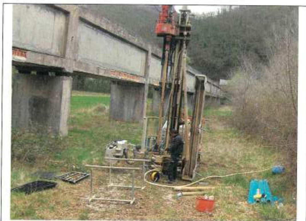
Postazione ed Esecuzione sondaggio S7
