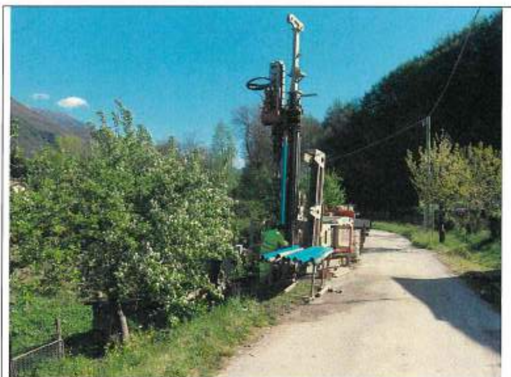
Istallazione piezometro in corrispondenza del sondaggio Si2
