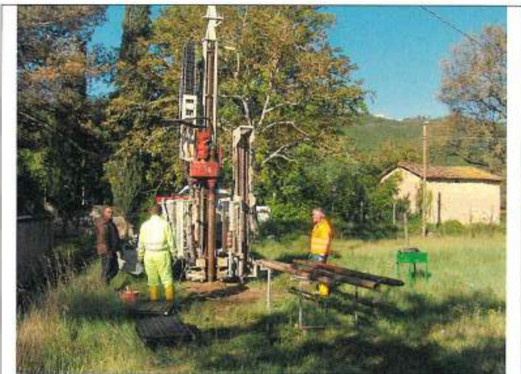
Postazione ed Esecuzione sondaggio Si3
