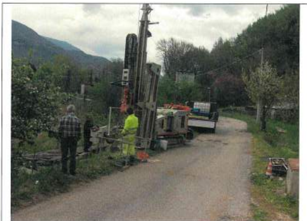
Postazione ed Esecuzione sondaggio Si2
