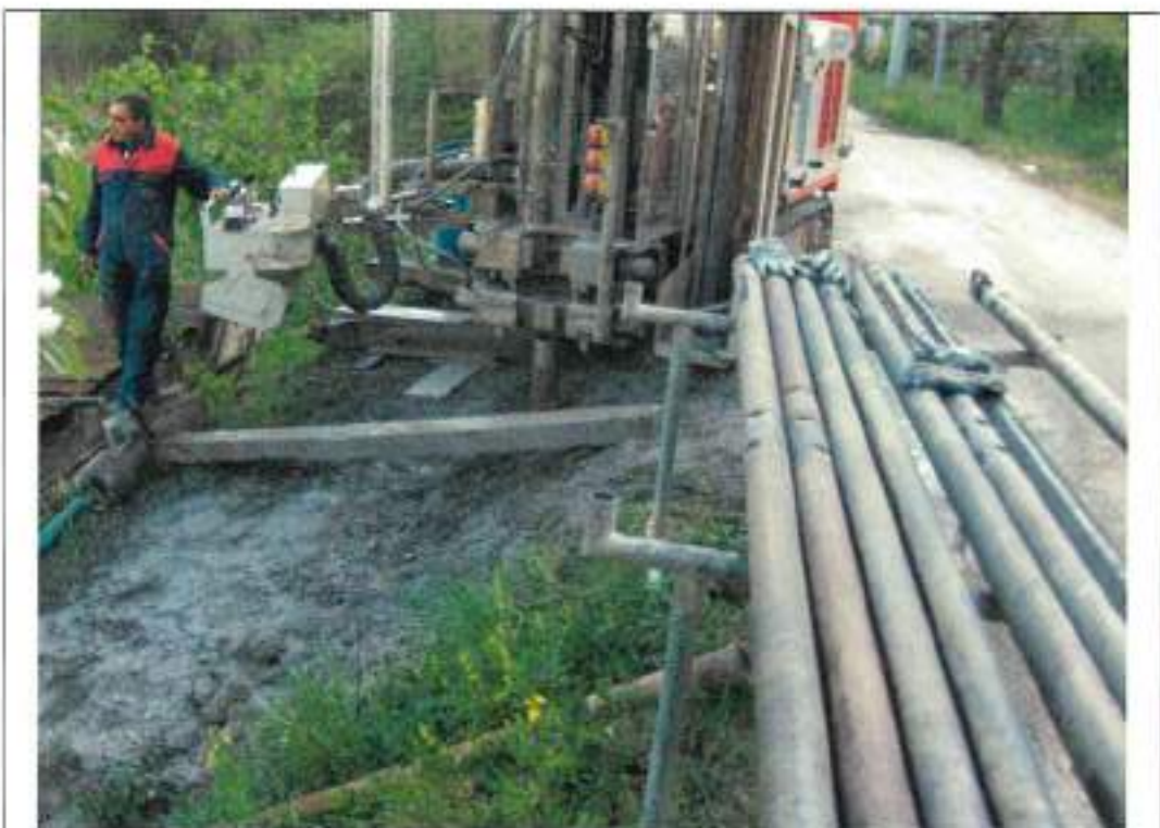
Esecuzione sondaggio Si2
