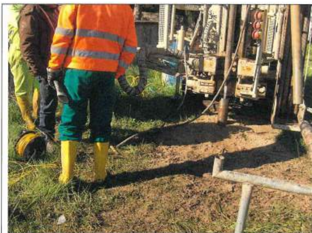
Esecuzione prove di permeabilità
