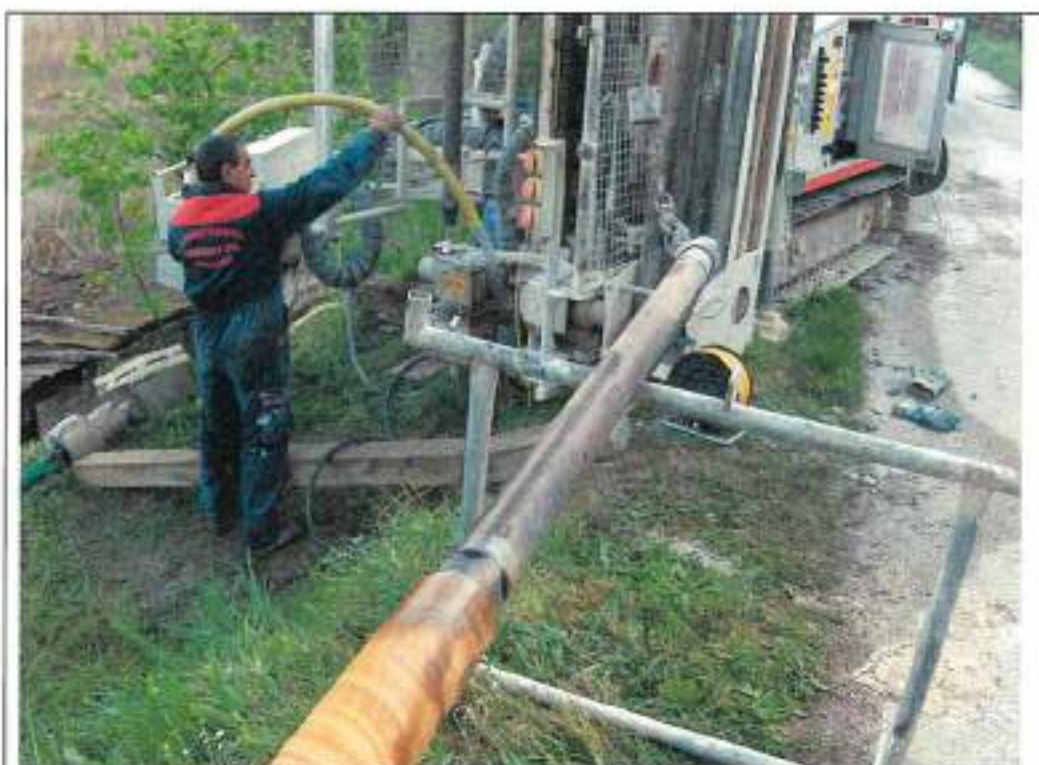
Esecuzione prove di permeabilità
