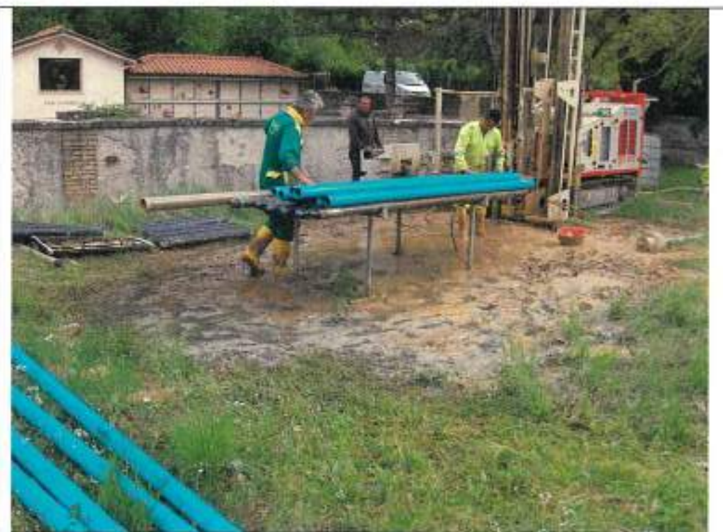
Istallazione piezometro in corrispondenza del sondaggio Si3
