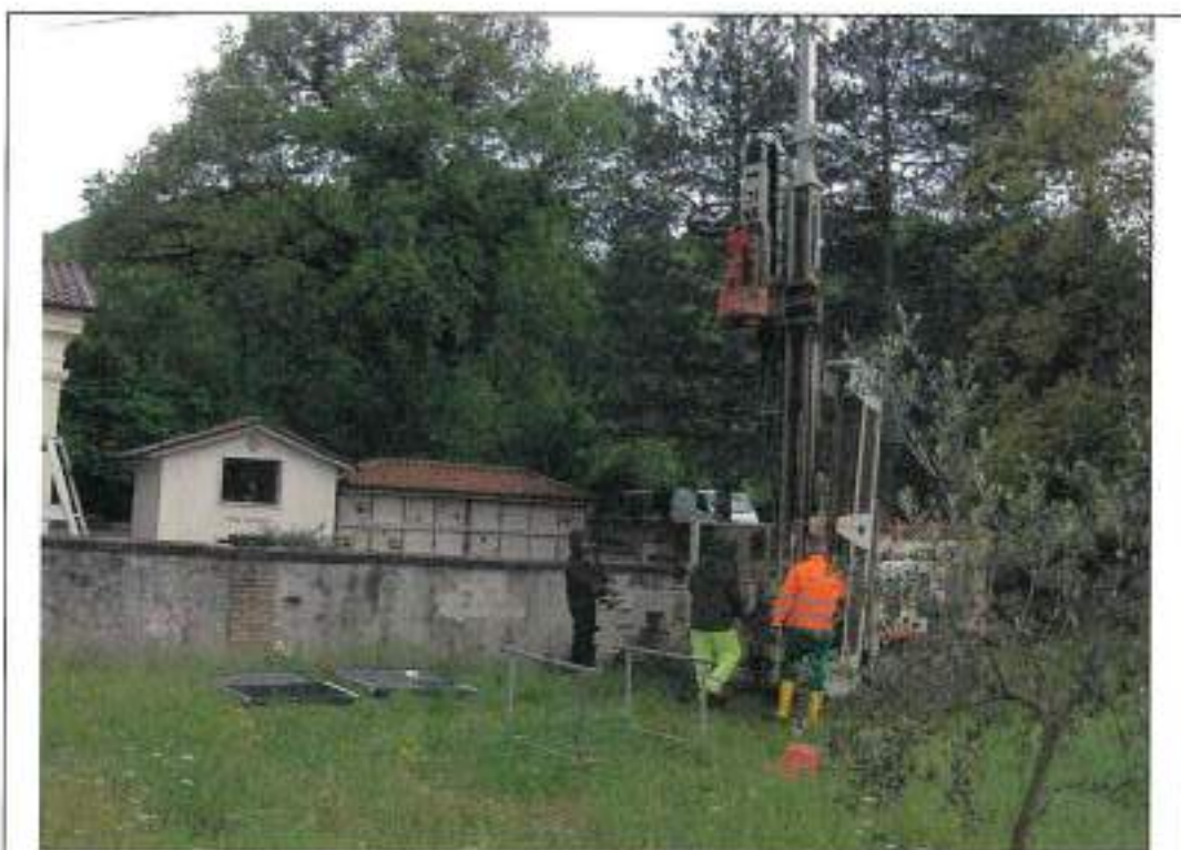
Postazione ed Esecuzione sondaggio Si3
