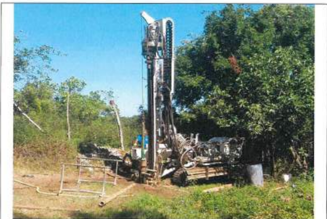
Esecuzione sondaggio S1(2)
