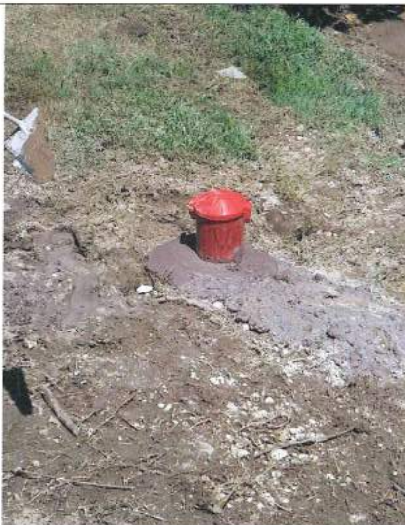
Installazione piezometro in corrispondenza del sondaggio S1(2)
