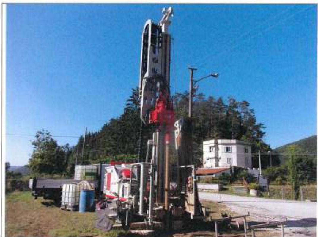
Postazione ed Esecuzione sondaggio S9(2)
