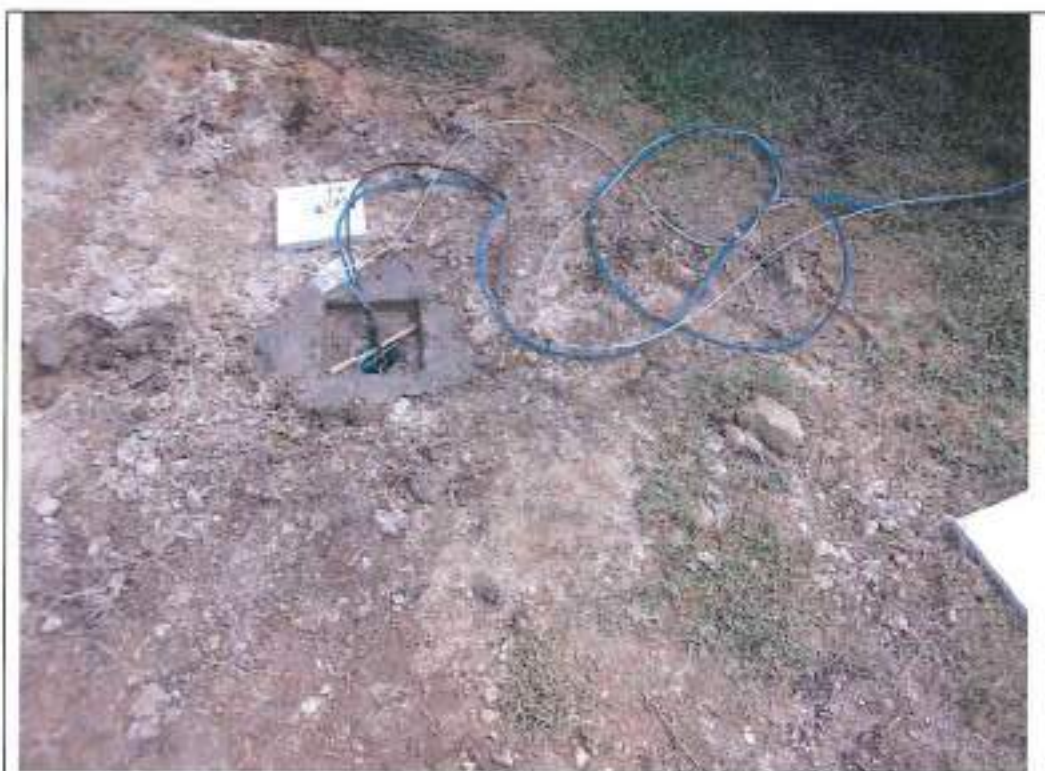
Esecuzione indagine Down-Hole in sondaggio S9(2)
