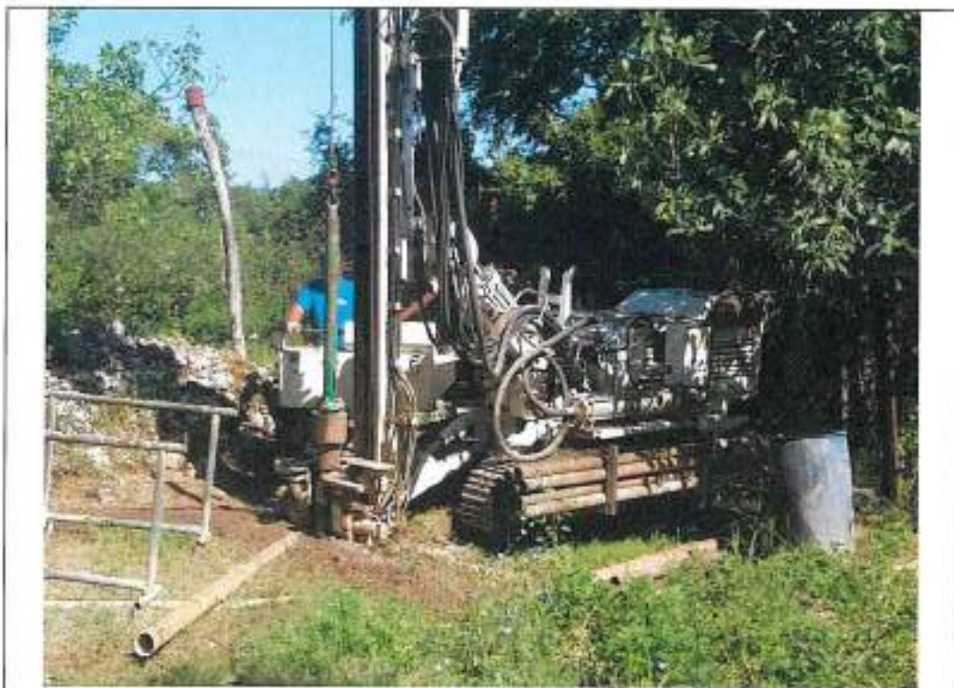
Postazione ed Esecuzione sondaggio S1(2)
