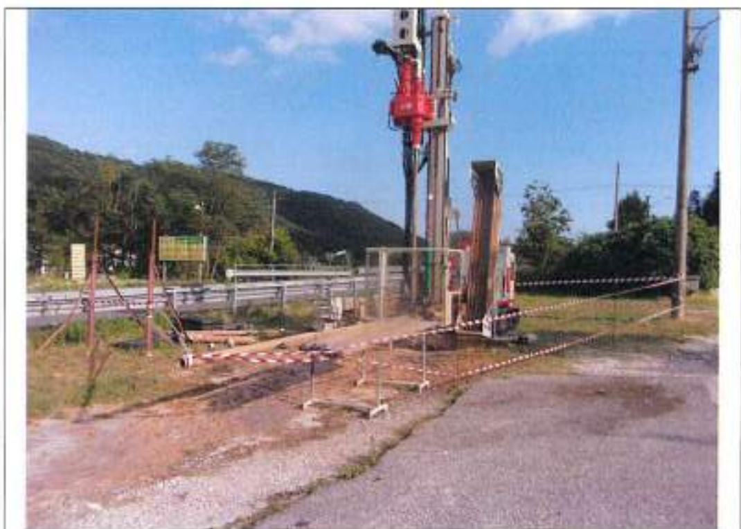
Esecuzione sondaggio S9(2)
