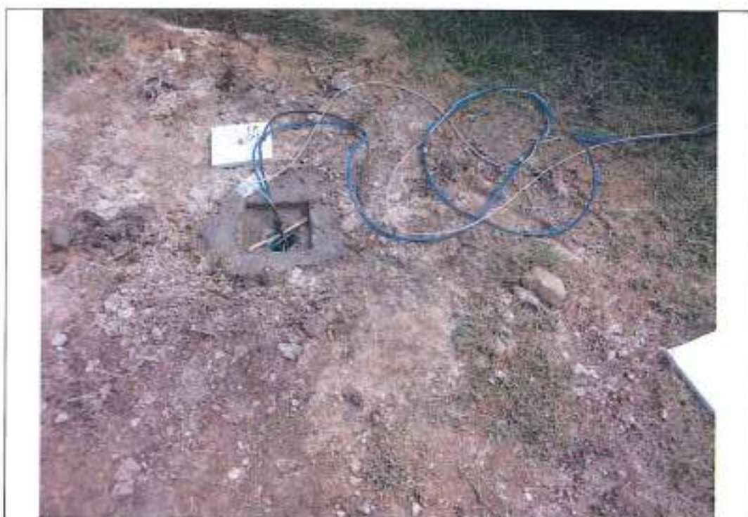
Esecuzione prove pressiometriche in sondaggio S9(2)
