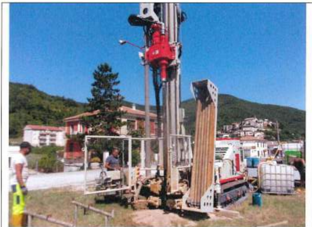
Postazione ed Esecuzione sondaggio S9 (pz)
