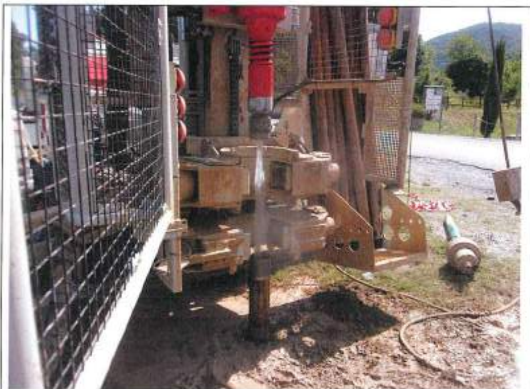
Riempimento foro con acqua per prova di permeabilità
