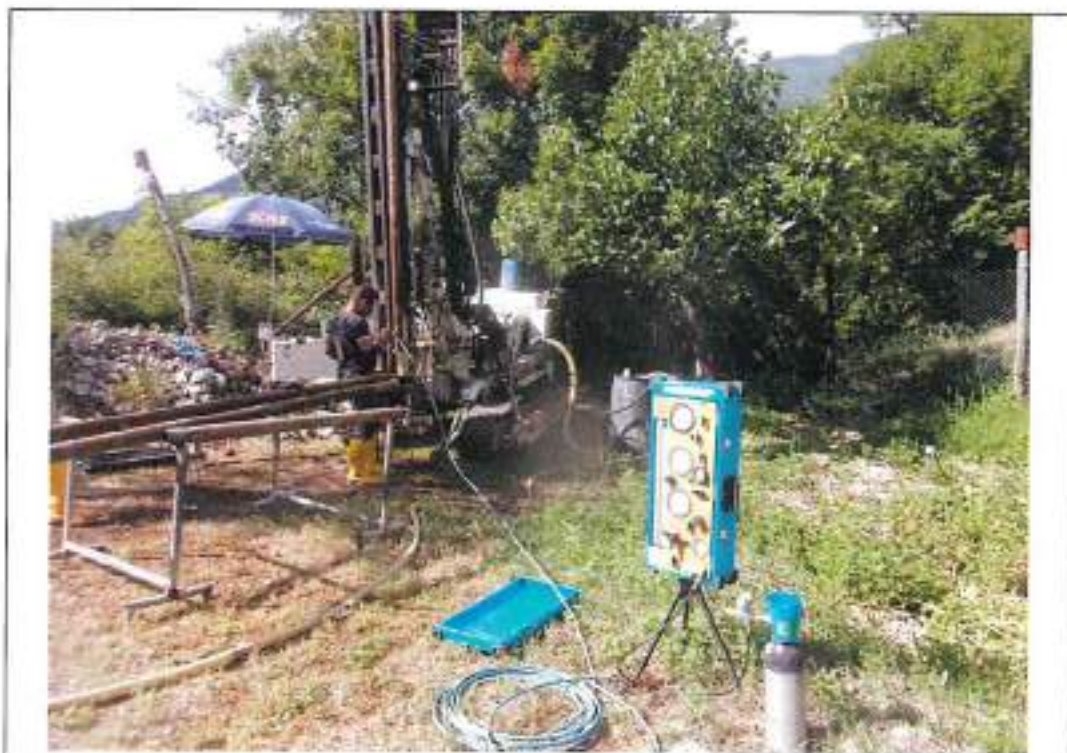
Esecuzione prove pressiometriche in sondaggio S1(2)
