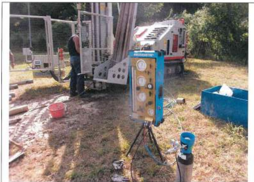
Esecuzione prove pressiometriche in sondaggio S10
