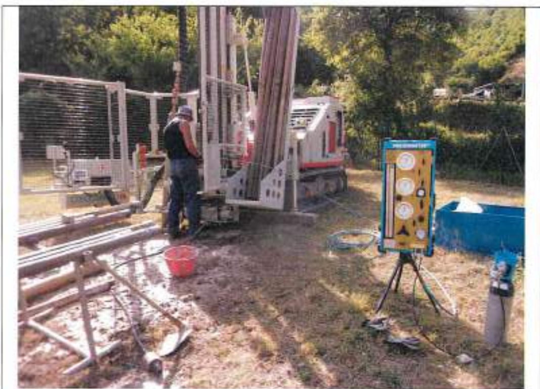
Esecuzione prove pressiometriche in sondaggio S10
