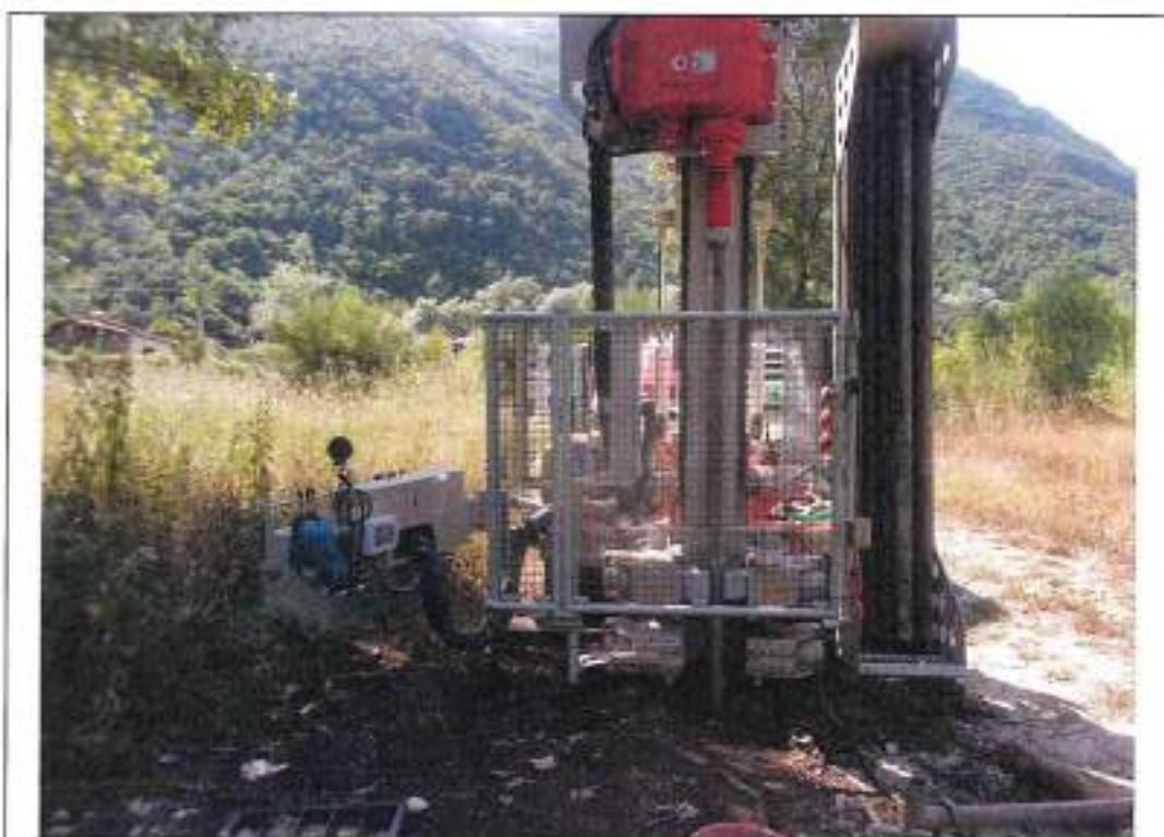
Postazione ed Esecuzione sondaggio S6
