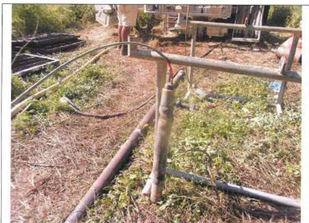
Esecuzione prove pressiometriche in sondaggio S4
