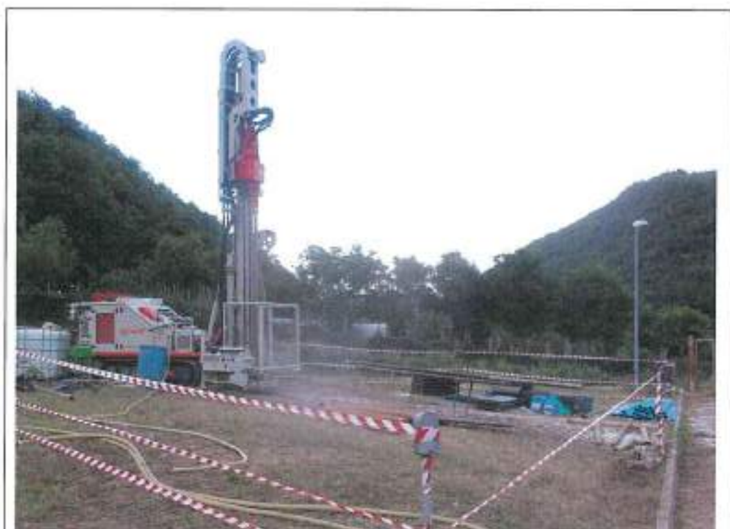
Tubi piezometrici in corrispondenza del sondaggio S10
