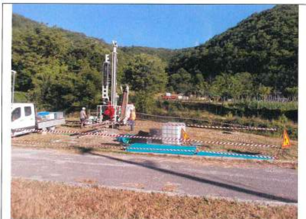
Postazione ed Esecuzione sondaggio S10 (2)
