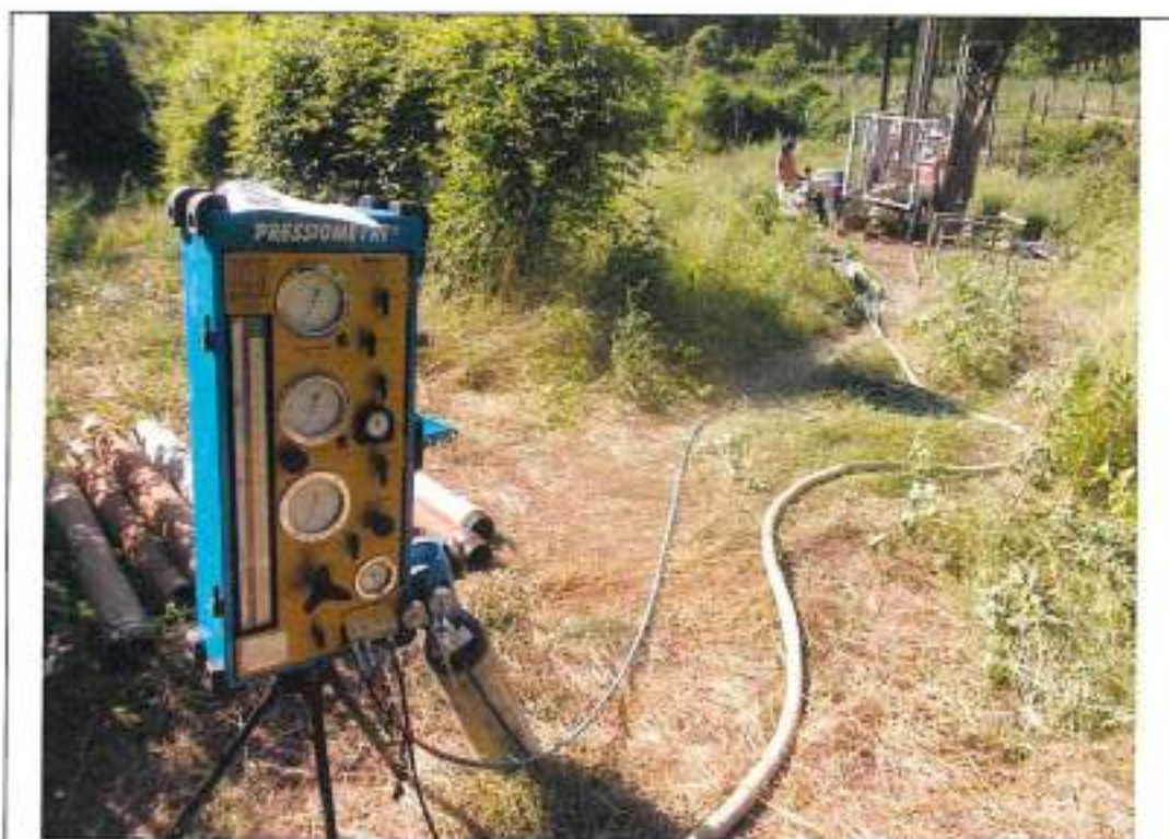
Esecuzione prove pressiometriche in sondaggio S4
