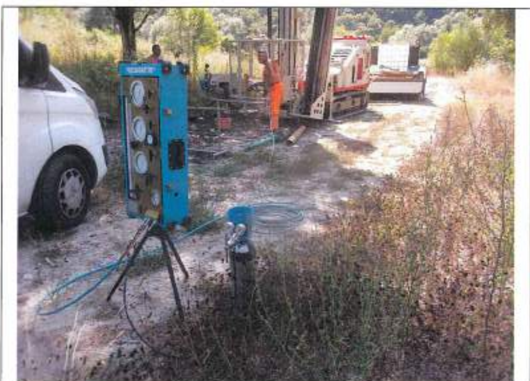
Esecuzione prove pressiometriche in sondaggio S6
