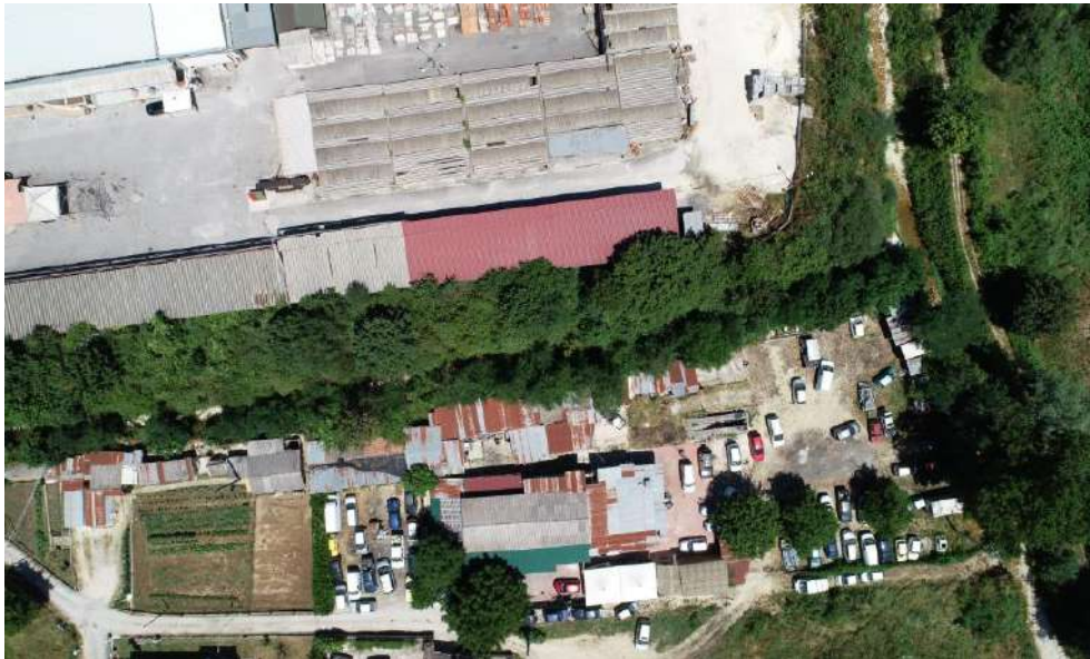
Figura 48 – Foto area da drone presso l’attraversamento vallivo del tracciato di progetto del Fosso Ariana – San Giovanni Reatino.
