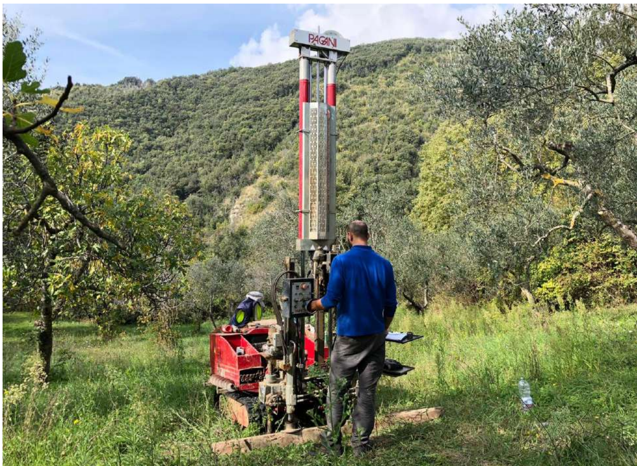
Figura 150 – Esecuzione della prova penetrometrica CPT.
