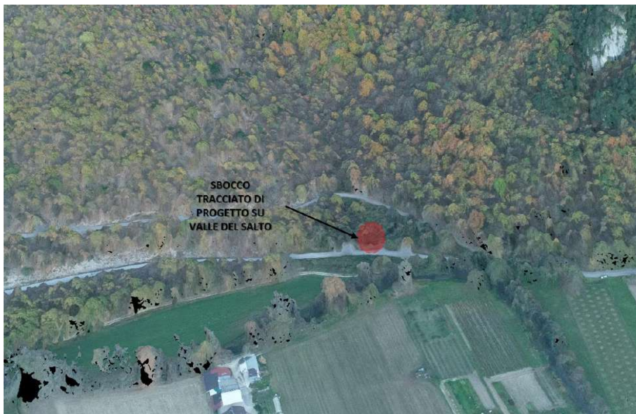
Figura 54 – Modello 3D costruito a seguito del rilievo aerofotogrammetrico da drone dello sbocco del tracciato di progetto sulla valle del Fiume Salto. Si nota la presenza di una fitta vegetazione, costituita da alberi ad alto fusto, e nessun elemento e/o forma riconducibili a fenomenologie di instabilità di versante.
