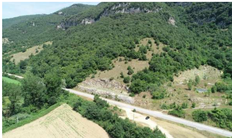
Figura 47 – Foto area da drone presso l’attraversamento vallivo del tracciato di progetto del Fiume Turano.
