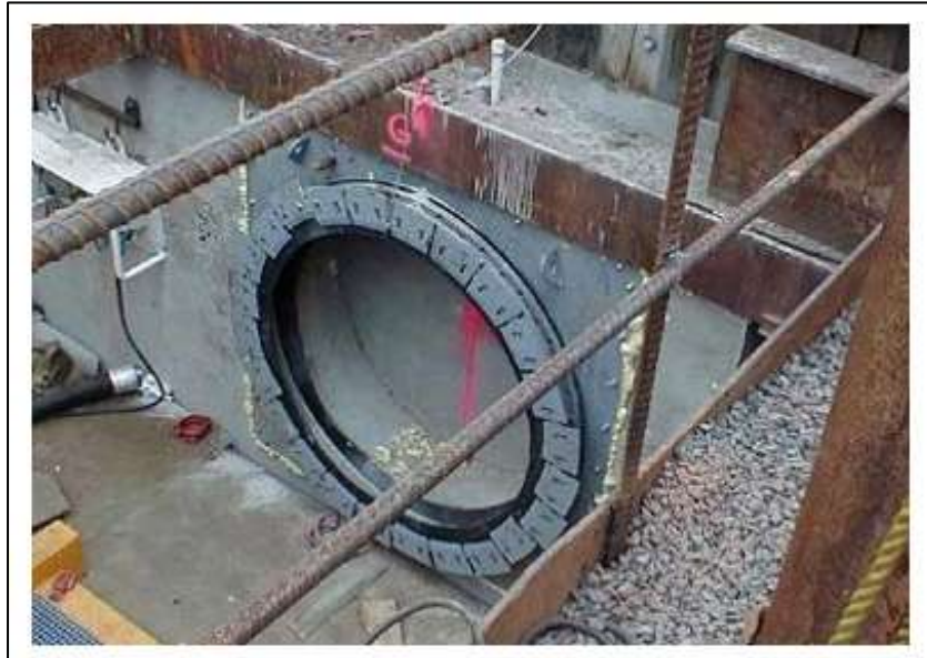
Figura 5.3 - Immagine della guarnizione di ingresso (da Herreknecht website)
