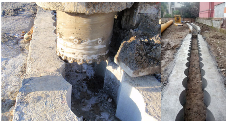
Figura 4.25 – Esempio di correa con sagoma delle perforazioni
