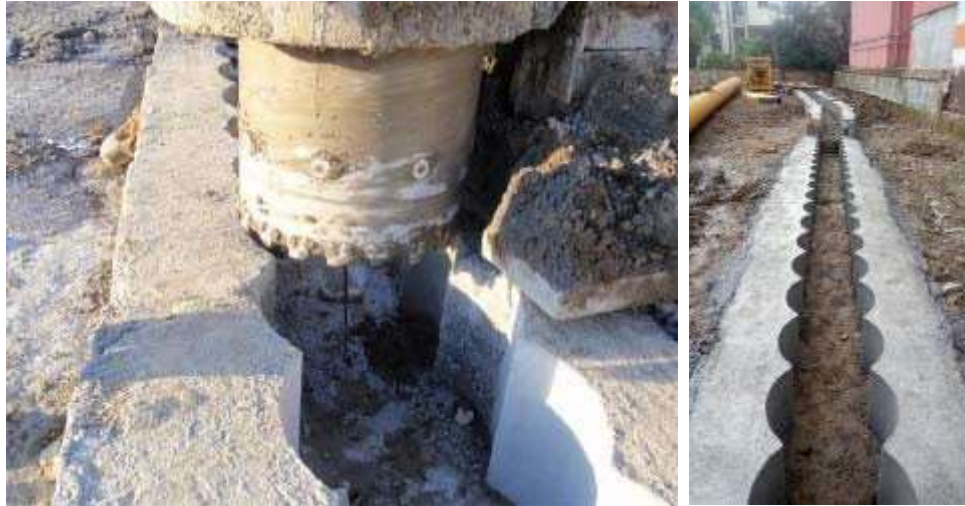
Figura 3.3 - Esempio di catena con sagoma delle perforazioni
