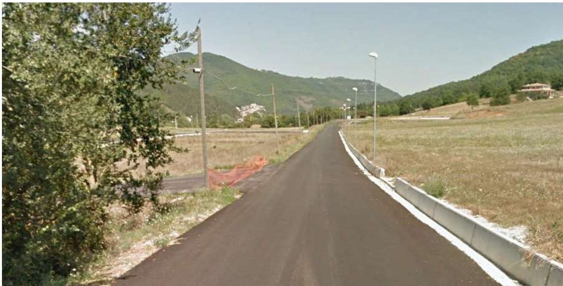
Figura 5.49 – Area di cantiere SGR 2 – Viabilità di accesso
