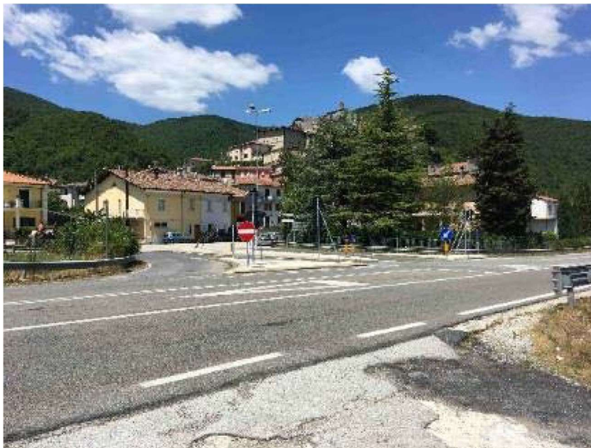
Figura 3.26 – SS.4 Salaria - area cantiere SGR
