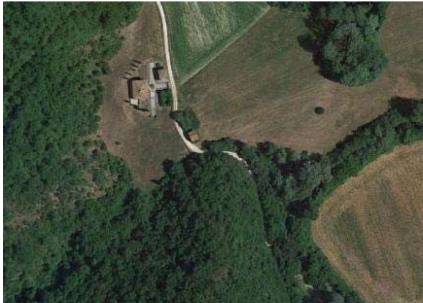
Figura 3.24 – Aree di cantiere Turano Valle
