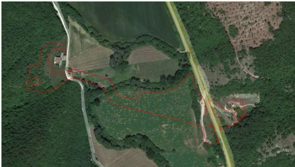
Figura 5.34 – Area di cantiere Valle del Turano
