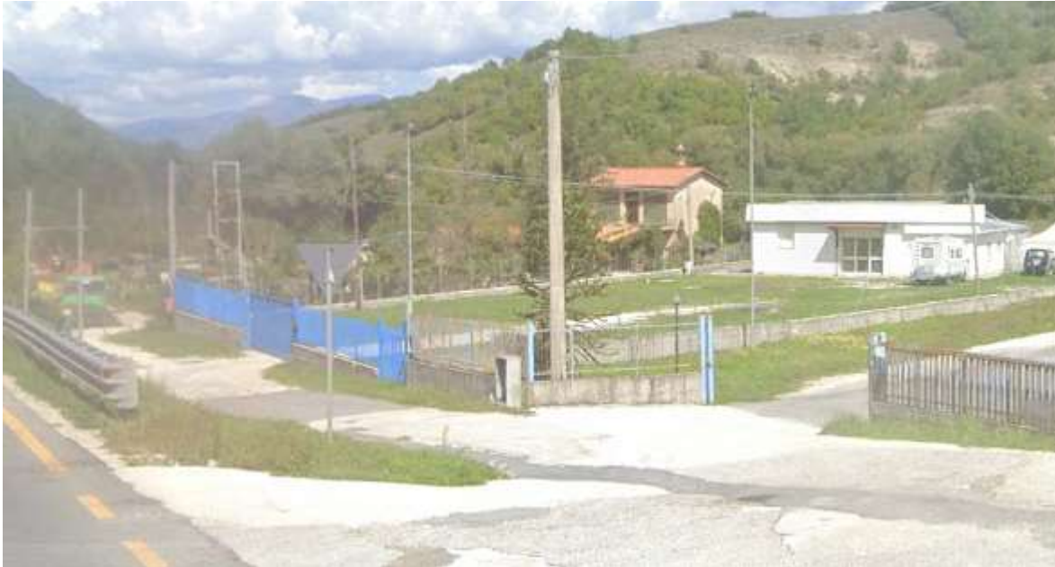
Figura 5.46 – Area di cantiere SGR – Zona Viabilità di accesso
