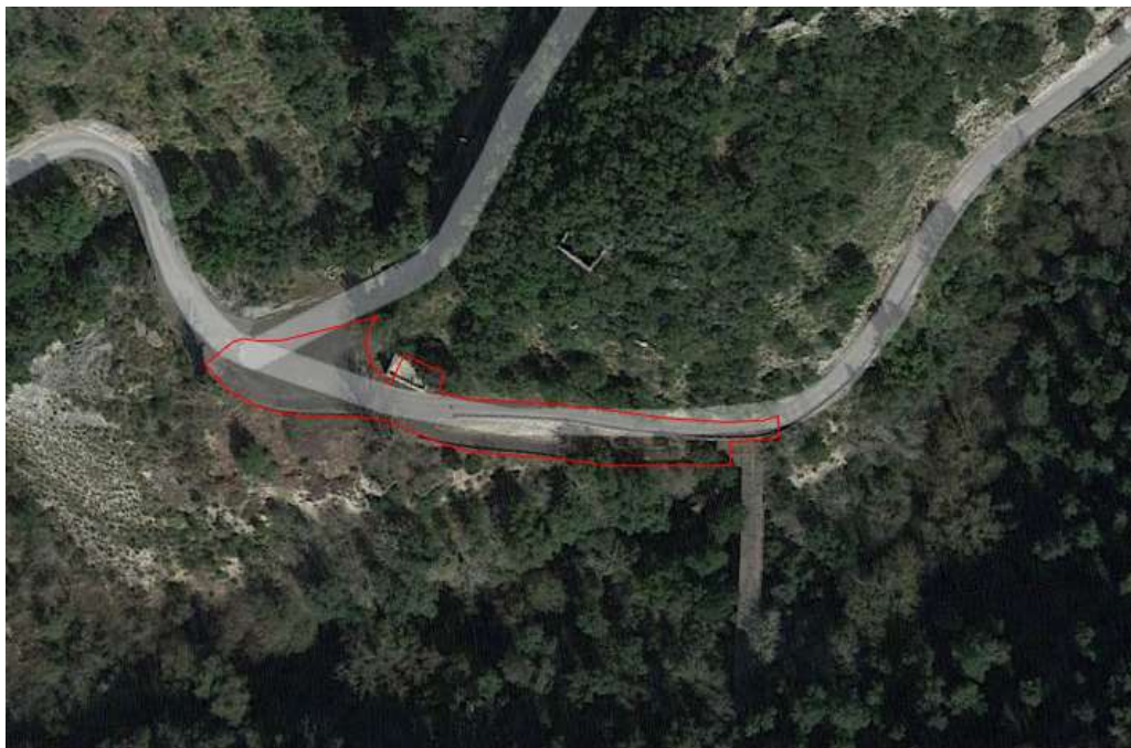
Figura 5.57 – Area di cantiere allaccio al Peschiera Inferiore SX
