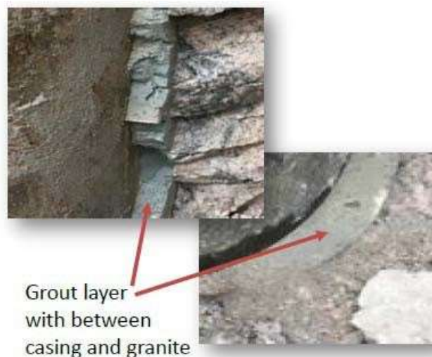
Figura 3.7 - Sovrascavo realizzato in O-Pile perforato in granito e riempito dal betoncino
