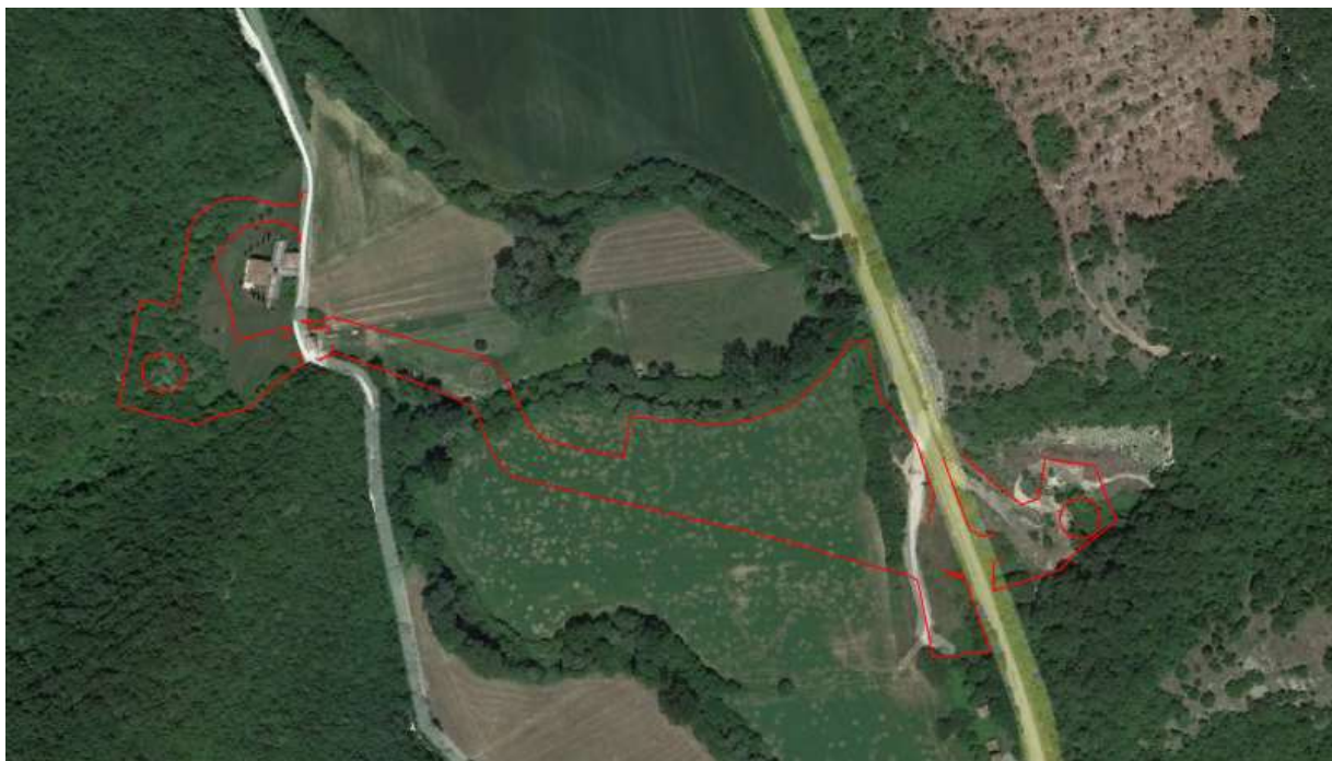
Figura 5.41 – Area di cantiere Valle del Turano
