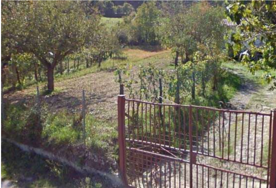
Figura 5.27 – Area di cantiere Finestra Cotilia – Viabilità di accesso
