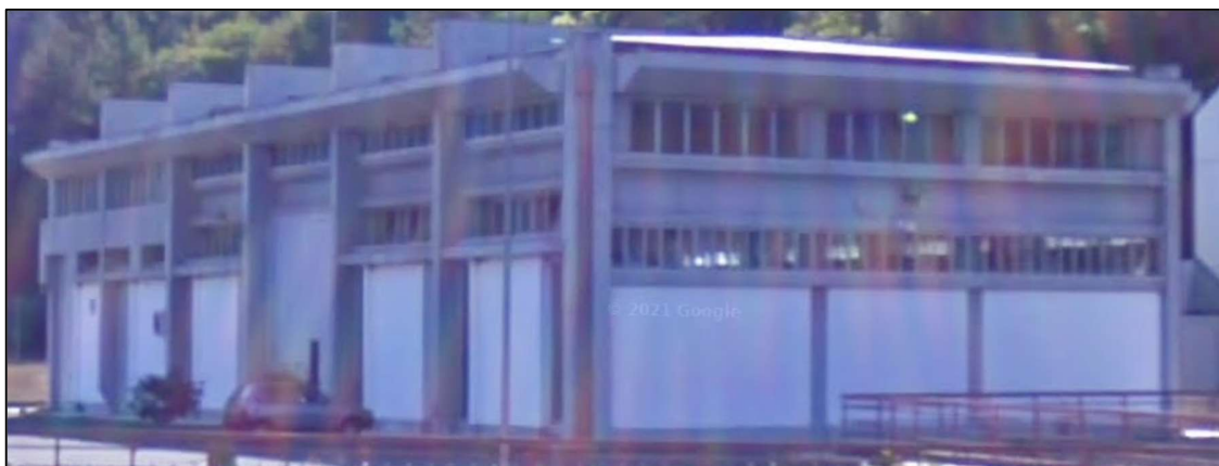
Figura 4.10 – Vista dell’edificio dalla strada adiacente il piazzale
