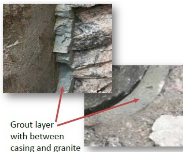
Figura 7.7 - Sovrascavo realizzato in O-Pile perforato in granito e riempito dal betoncino
