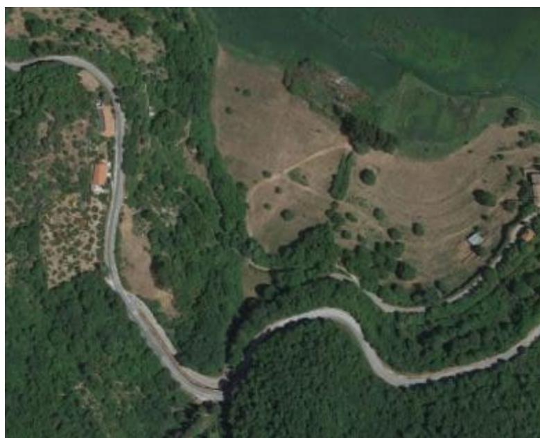
Figura 8.8 – Aree di cantiere M5
