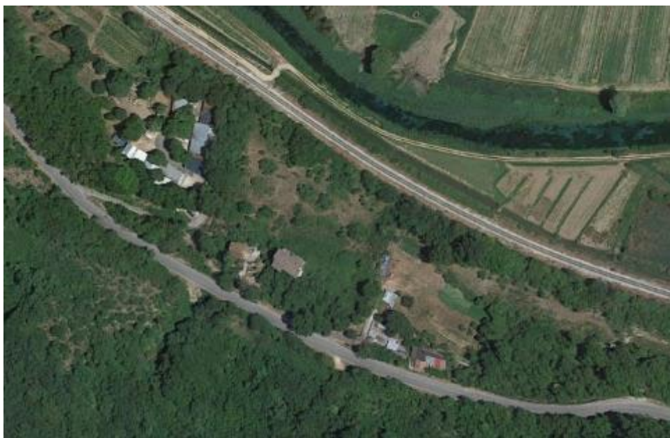
Figura 8.9 – Aree di cantiere M6 – NMP_A – uscita galleria Ponzano
