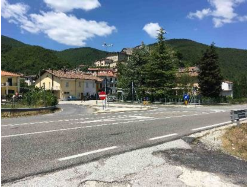
Figura 8.17 – SS.4 Salaria - area cantiere SGR
