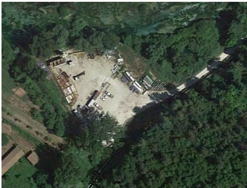
Figura 8.5 – Aree di cantiere M2
