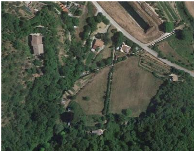
Figura 8.10 – Area di cantiere Finestra Cotilia
