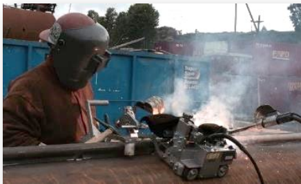
Figura 7.6 - Gargame ad omega durante la fase di saldatura lungo il fusto del lamierino.
