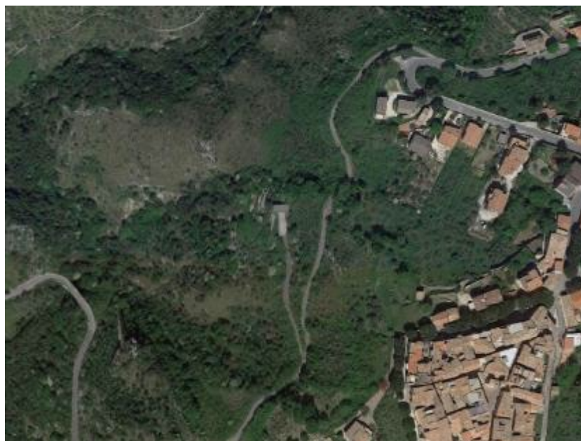
Figura 8.20 – Aree di cantiere vasca di carico
