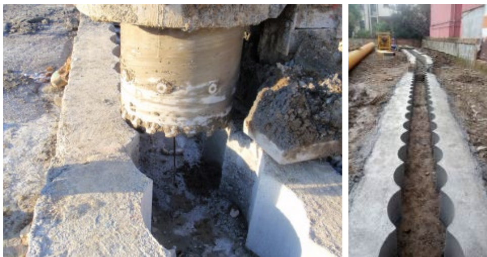
Figura 7.3 - Esempio di correa con sagoma delle perforazioni
