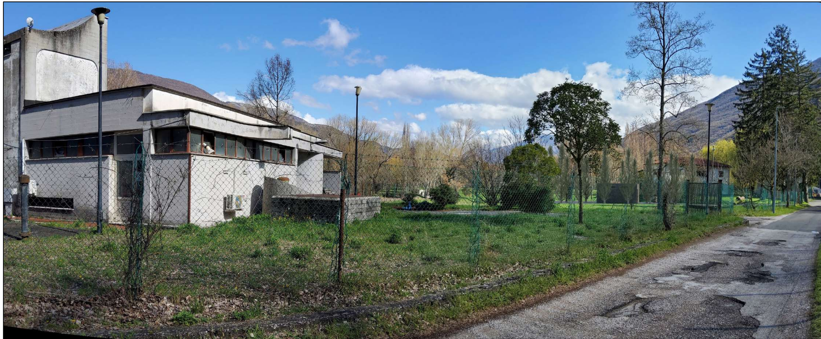
Fotoinserimento con interventi di inserimento da PV-SV-05 – inizio primavera
