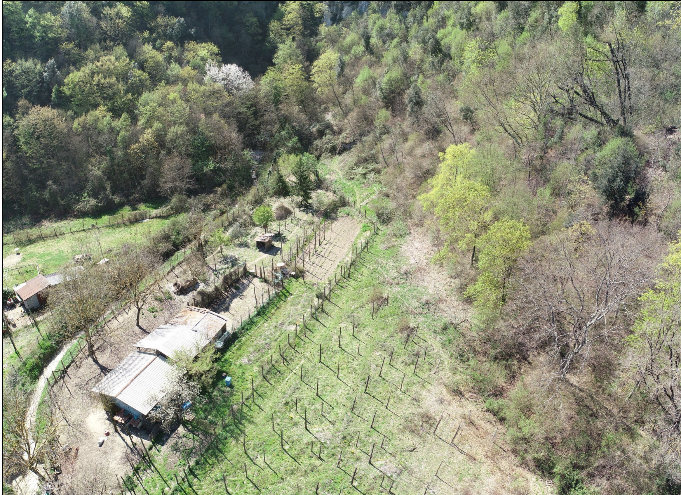
Vista da Drone PVVU-SA-02 – inizio primavera
