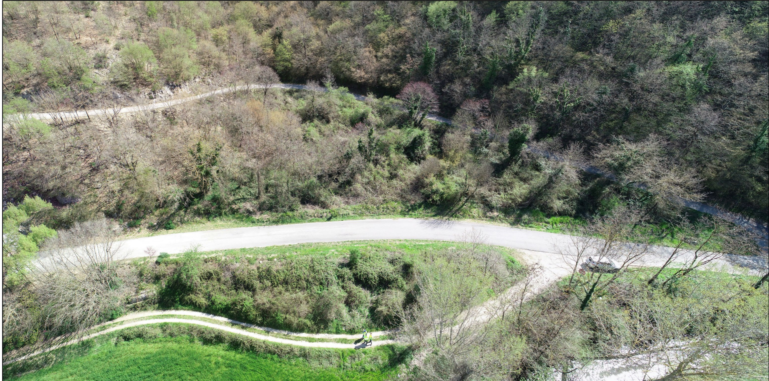
Vista da Drone PVVU-SA-01 – inizio primavera
