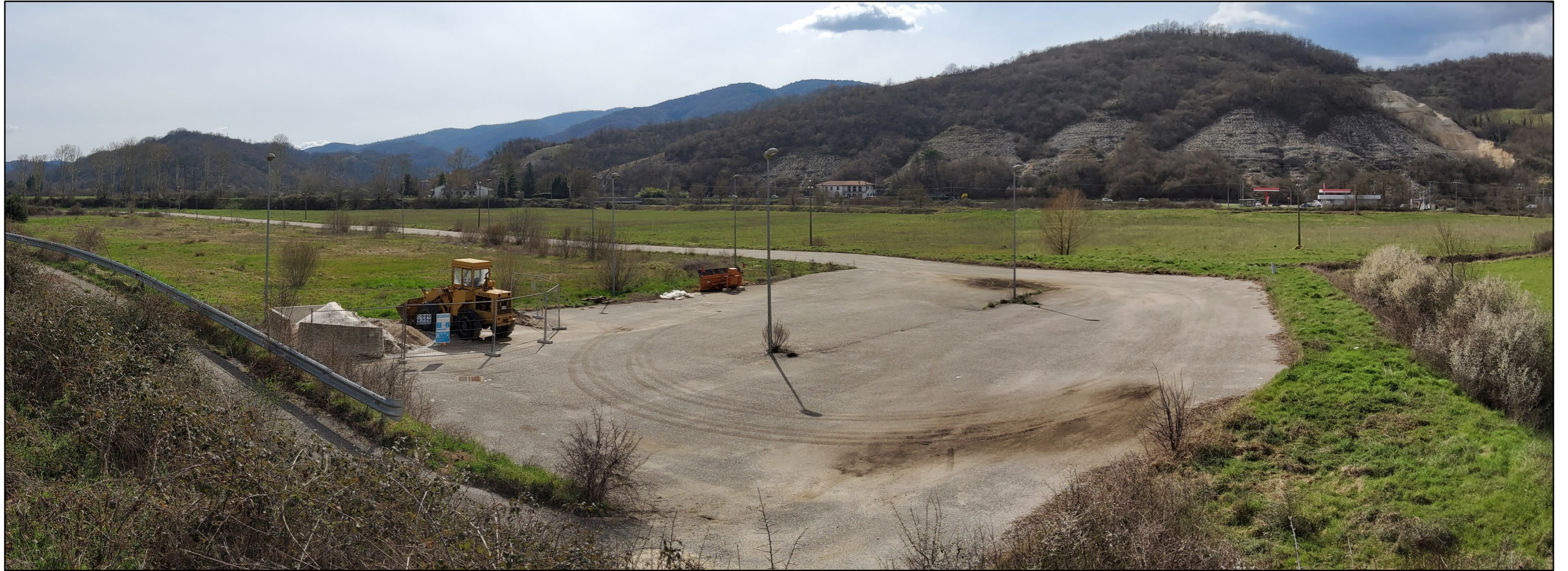
Vista da PV-SGR-03 – inizio primavera
