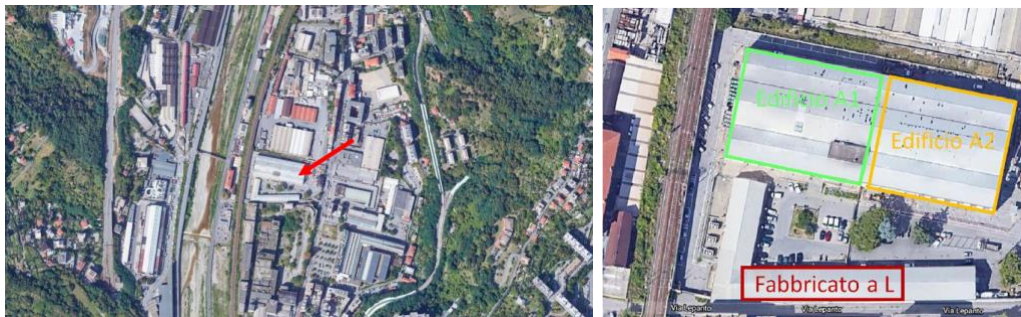
Figura 2 Vista fabbricati oggetto di intervento
