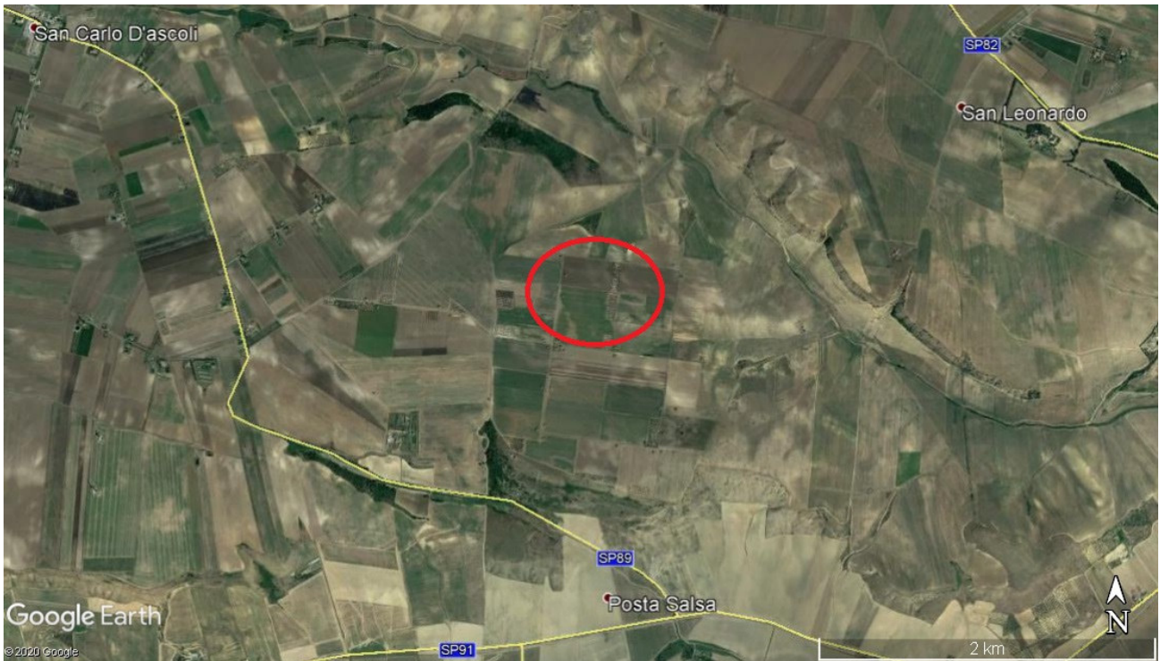
Fig. 2, In alto e in rosso è cerchiata l'area d'intervento estratta da Google Earth.
