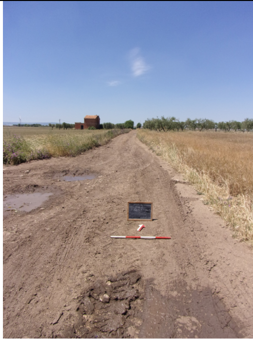
Fig. 20, percorso dell'elettrodotto su strada di campagna, scattata da sud
