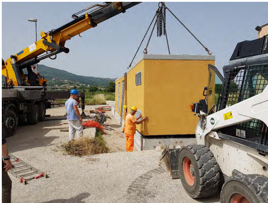
Figura 84 Esempio di posizionamento delle cabine
