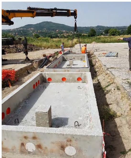
Figura 83 Esempio di basamento delle cabine
