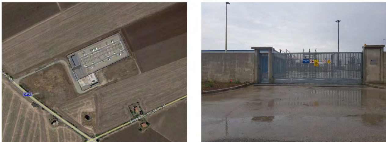
Figura 38 Foto sottostazione elettrica
