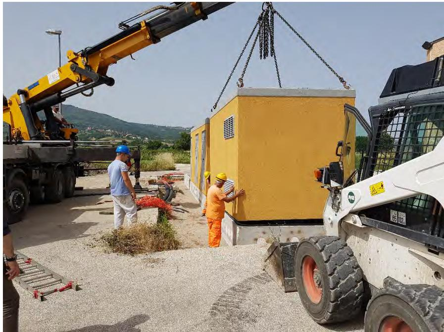
**Figura 66 Esempio di posizionamento delle cabine**
