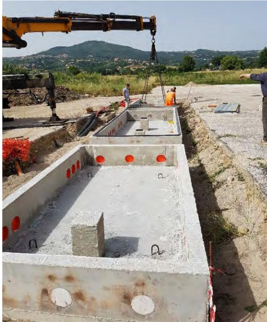
**Figura 65 Esempio di basamento delle cabine**
