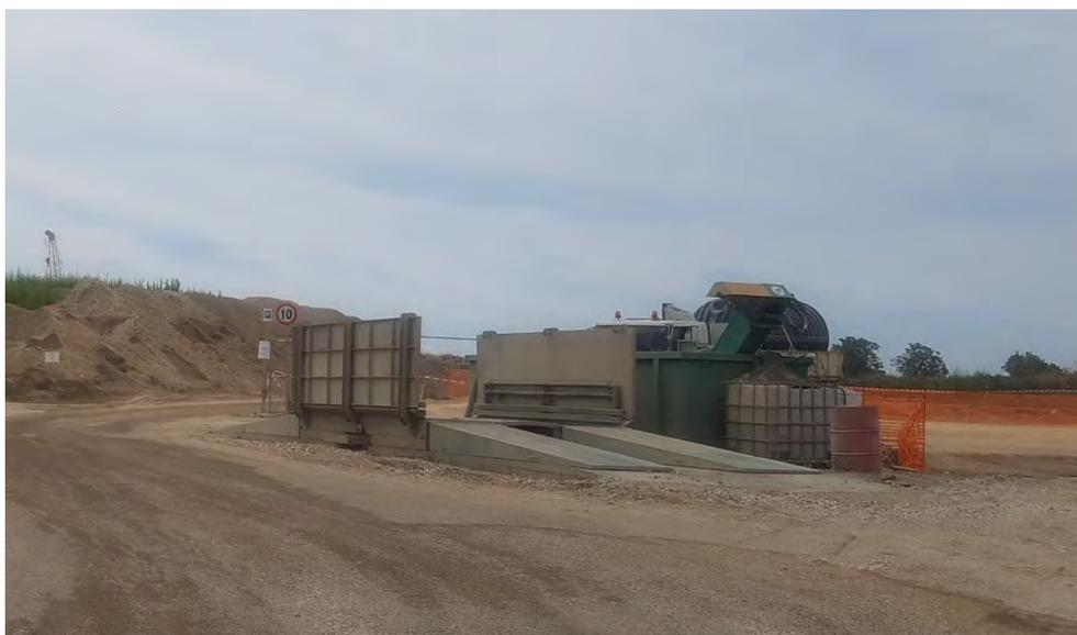
**Figura 46 Esempio di impianto automatico lavaggio ruote mezzi d'opera**
