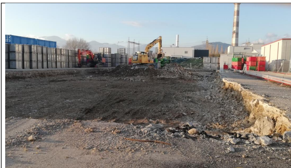
Area di scavo del Deposito D2
