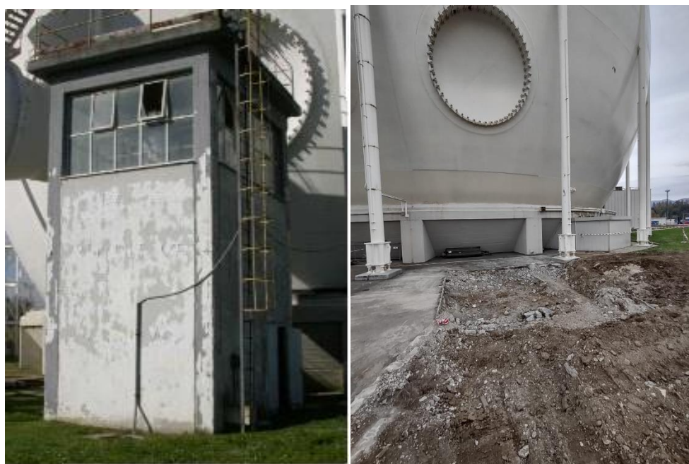
Figura 2.1 Edificio Tiosolfato – prima e dopo la demolizione
