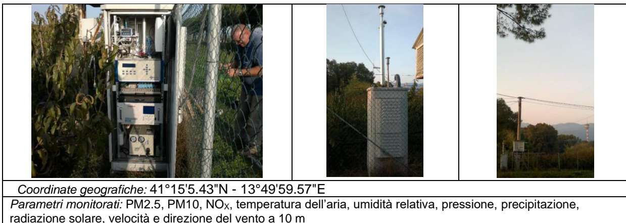
Figura 4.1 Cabina di monitoraggio
