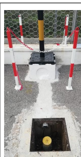
Installazione delle sonde nei piezometri
