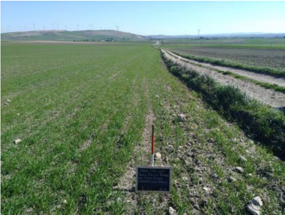
Figura 9. Cavidotto per torre 2
