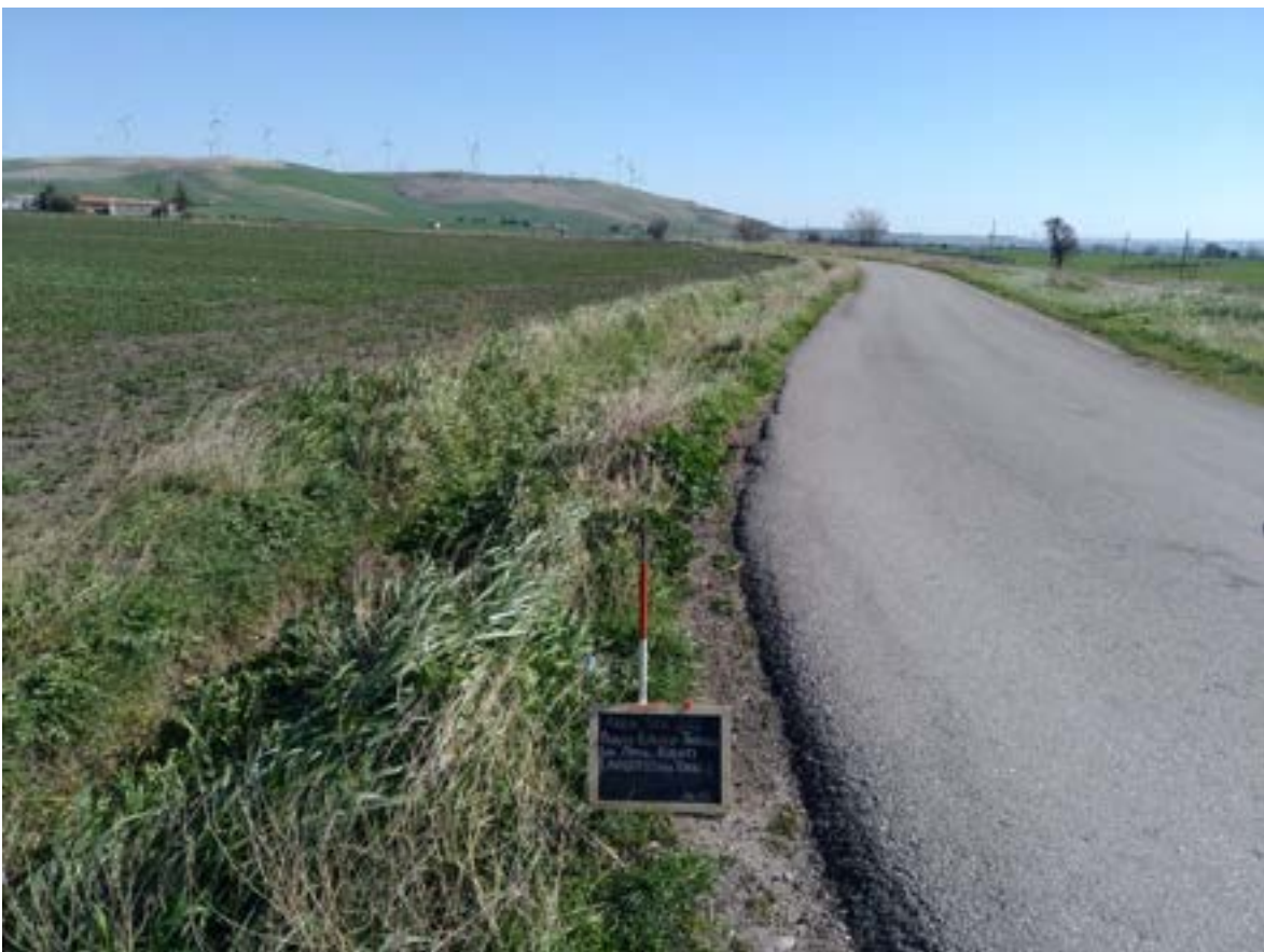
Figura 12. Cavidotto per torre 2
