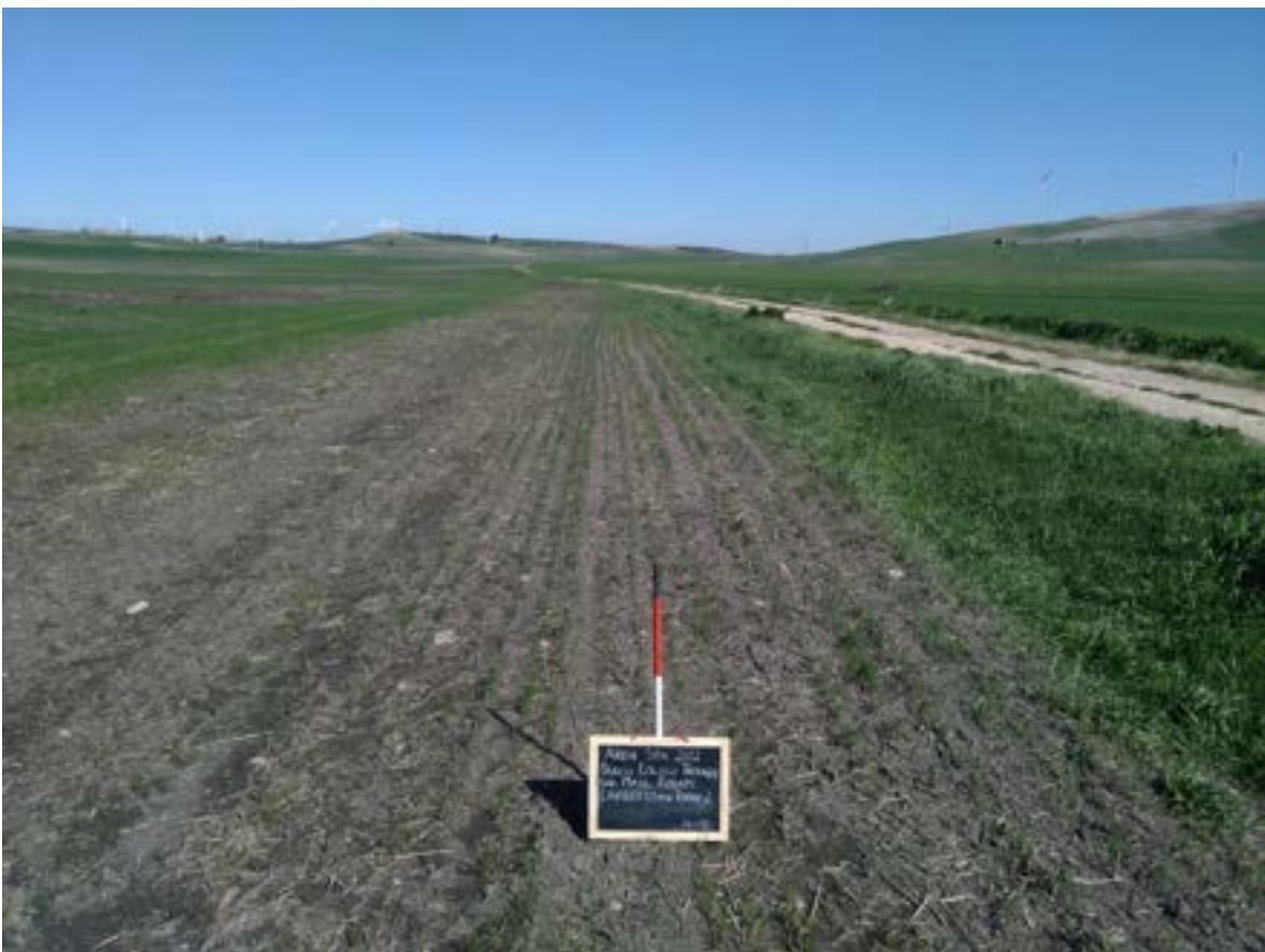
Figura 14. Cavidotto per torre 2
