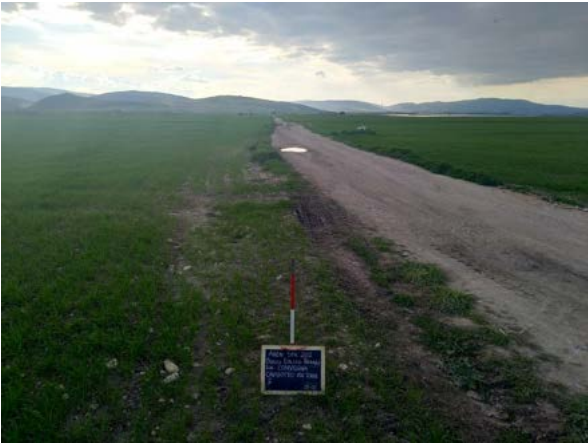
Figura 61. Cavidotto per torre 15
