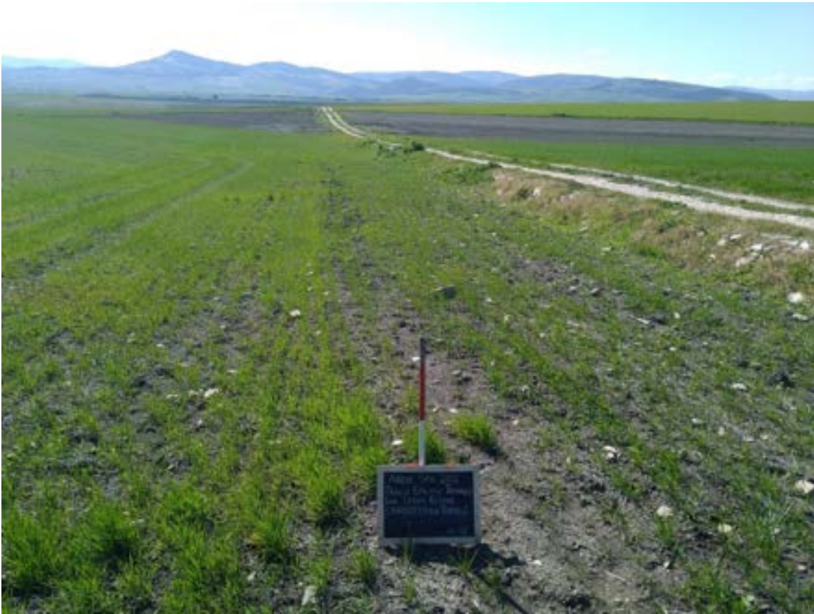
Figura 7. Cavidotto per torre 2
