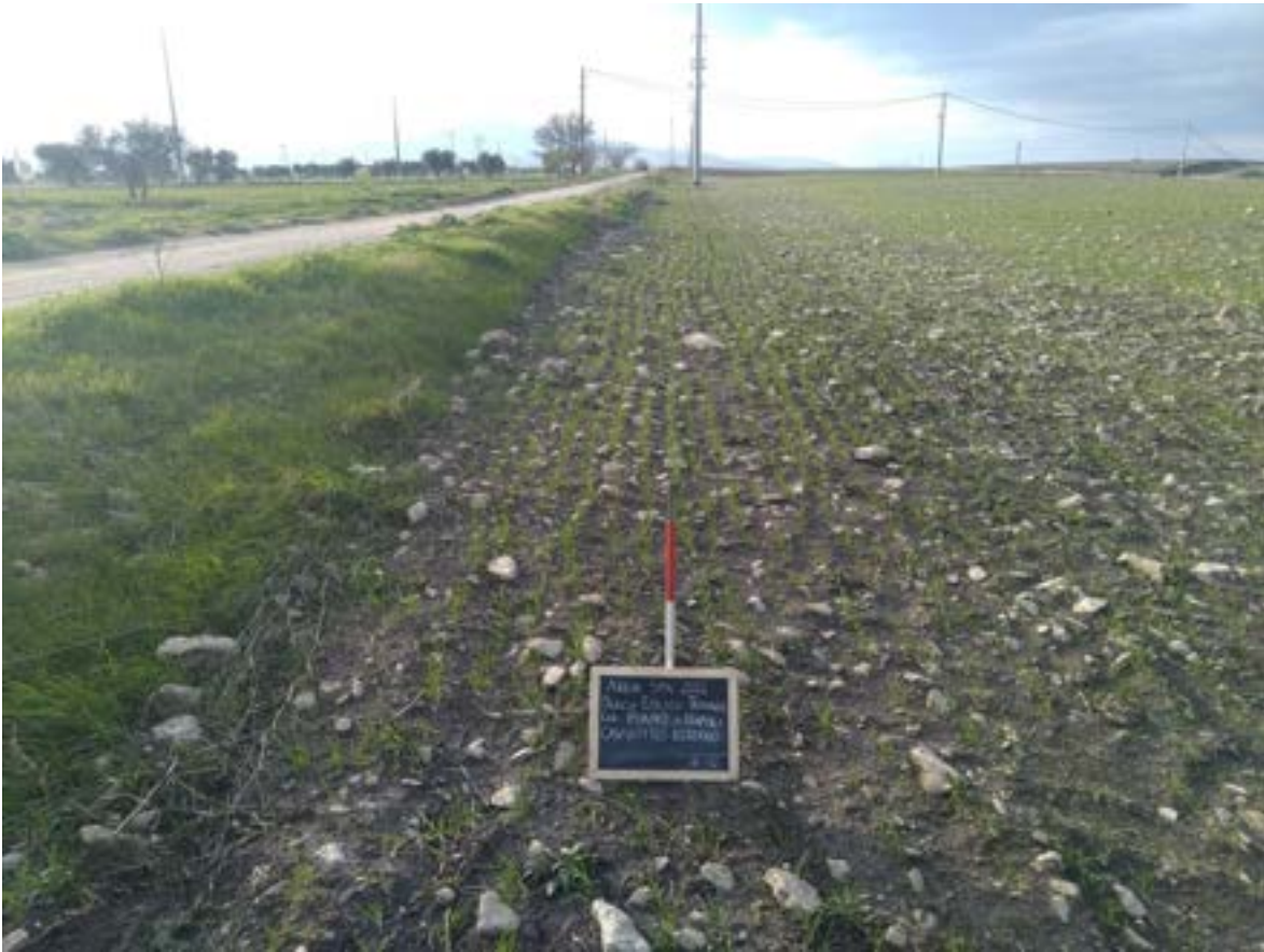
Figura 143. Cavidotto esterno II tratto
