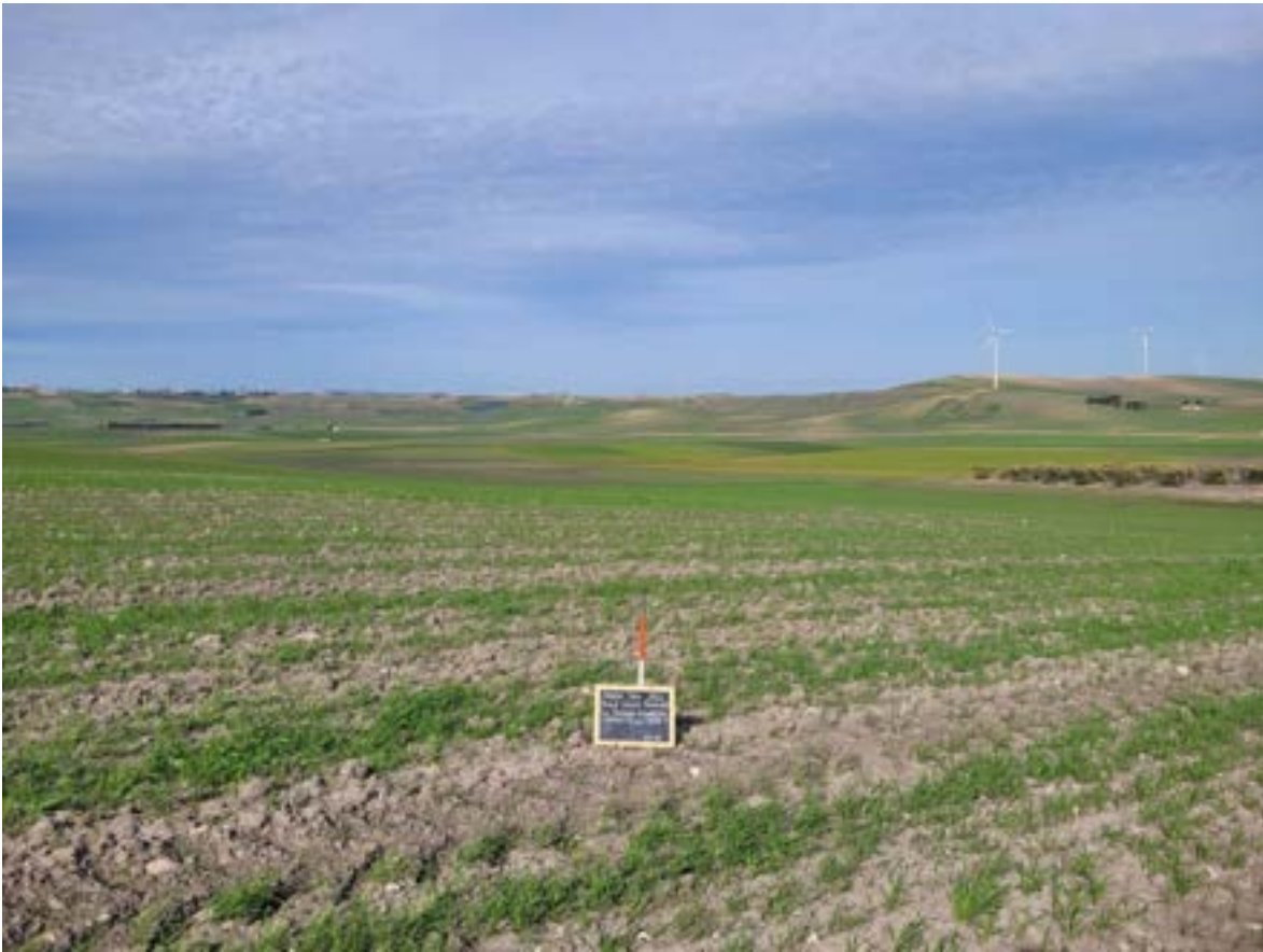
Figura 106. Cavidotto per torre 9
