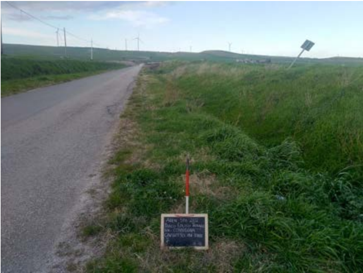
Figura 59. Cavidotto per torre 15
