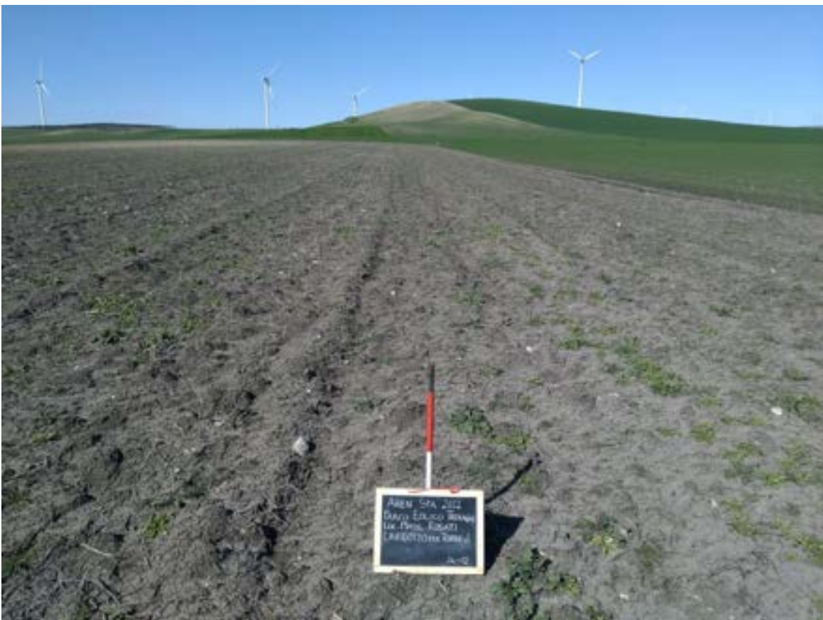
Figura 16. Cavidotto per torre 2
