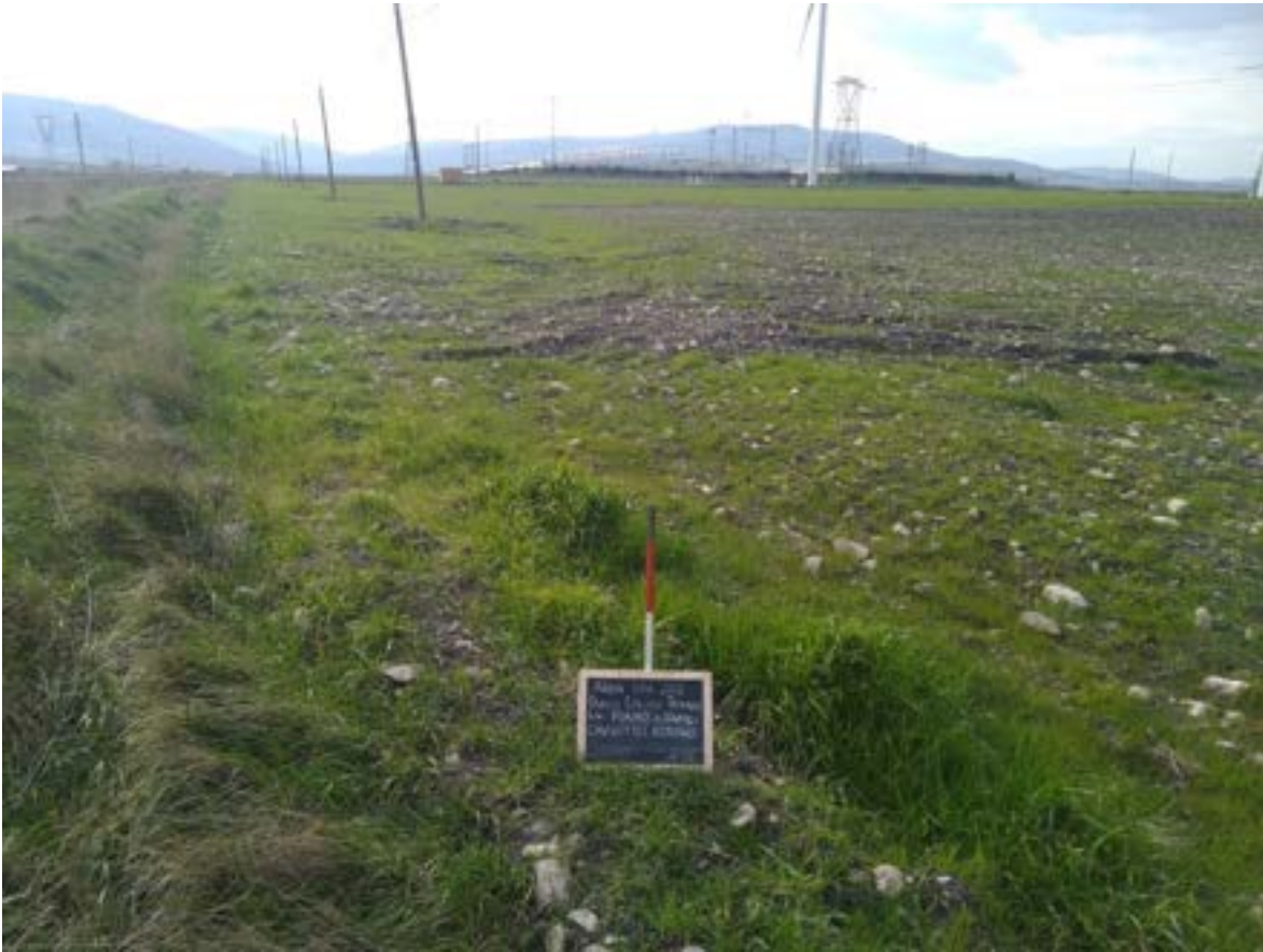
Figura 145. Cavidotto esterno II tratto
