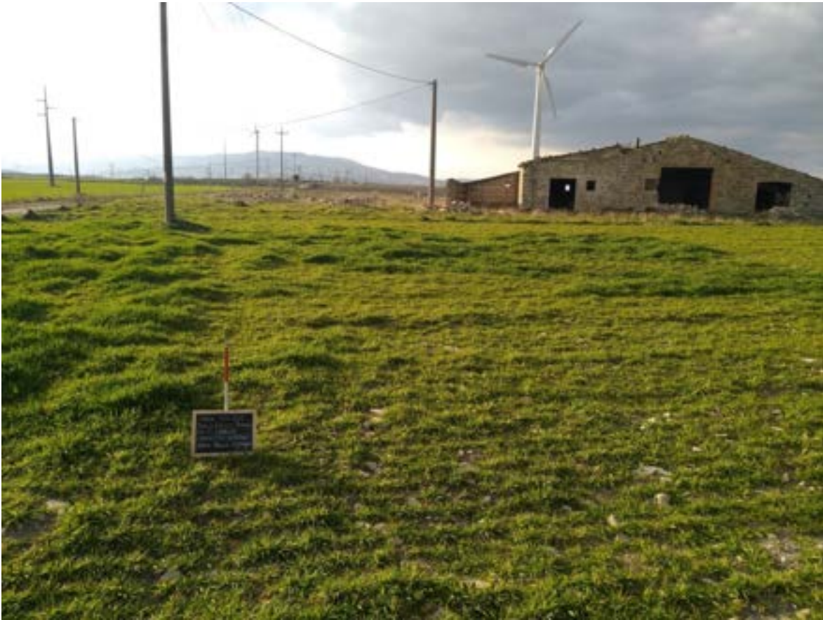
Figura 141. Cavidotto esterno II tratto
