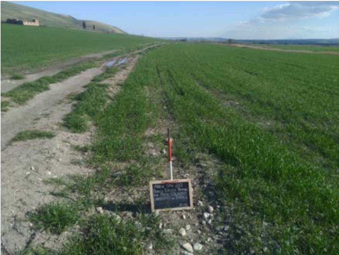
Figura 45. Cavidotto per torre 6
