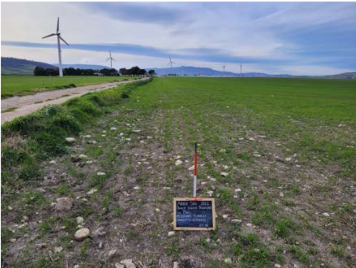
Figura 131. Cavidotto esterno I tratto
