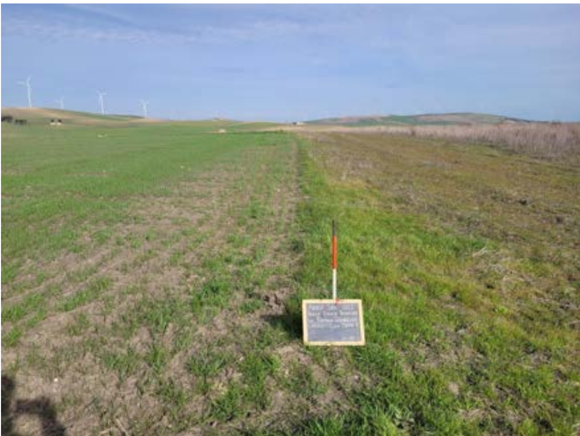
Figura 109. Cavidotto per torre 9
