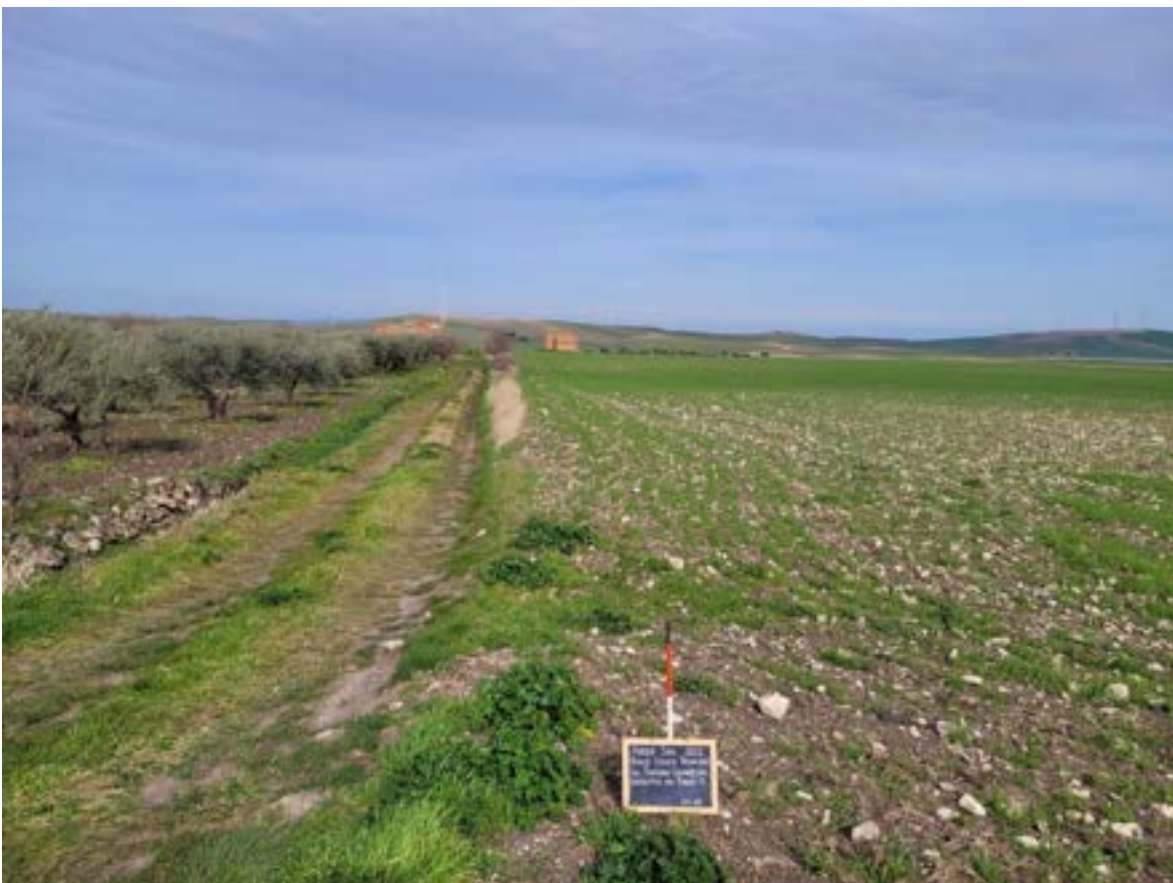
Figura 100. Cavidotto per torre 11
