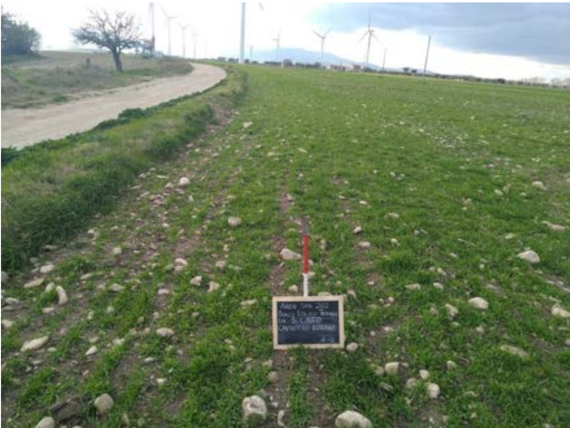
Figura 138. Cavidotto esterno II tratto
