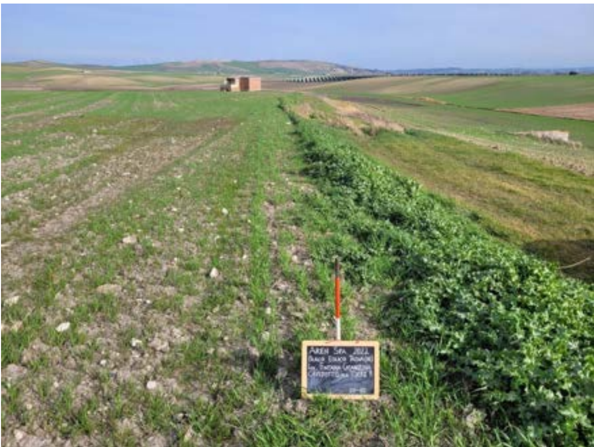
Figura 105. Cavidotto per torre 9
