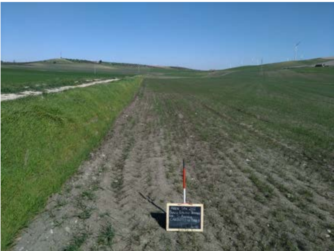
Figura 21. Cavidotto per torre 3
