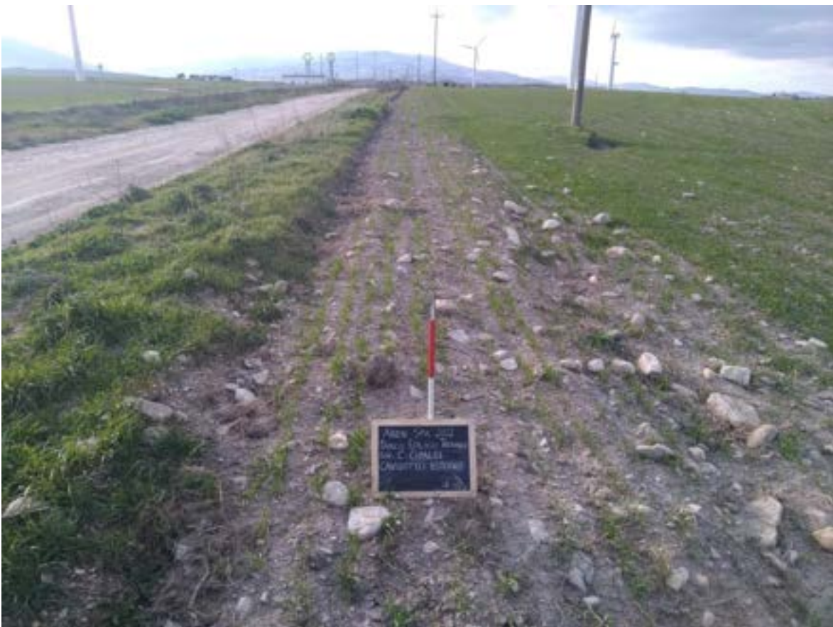
Figura 140. Cavidotto esterno II tratto
