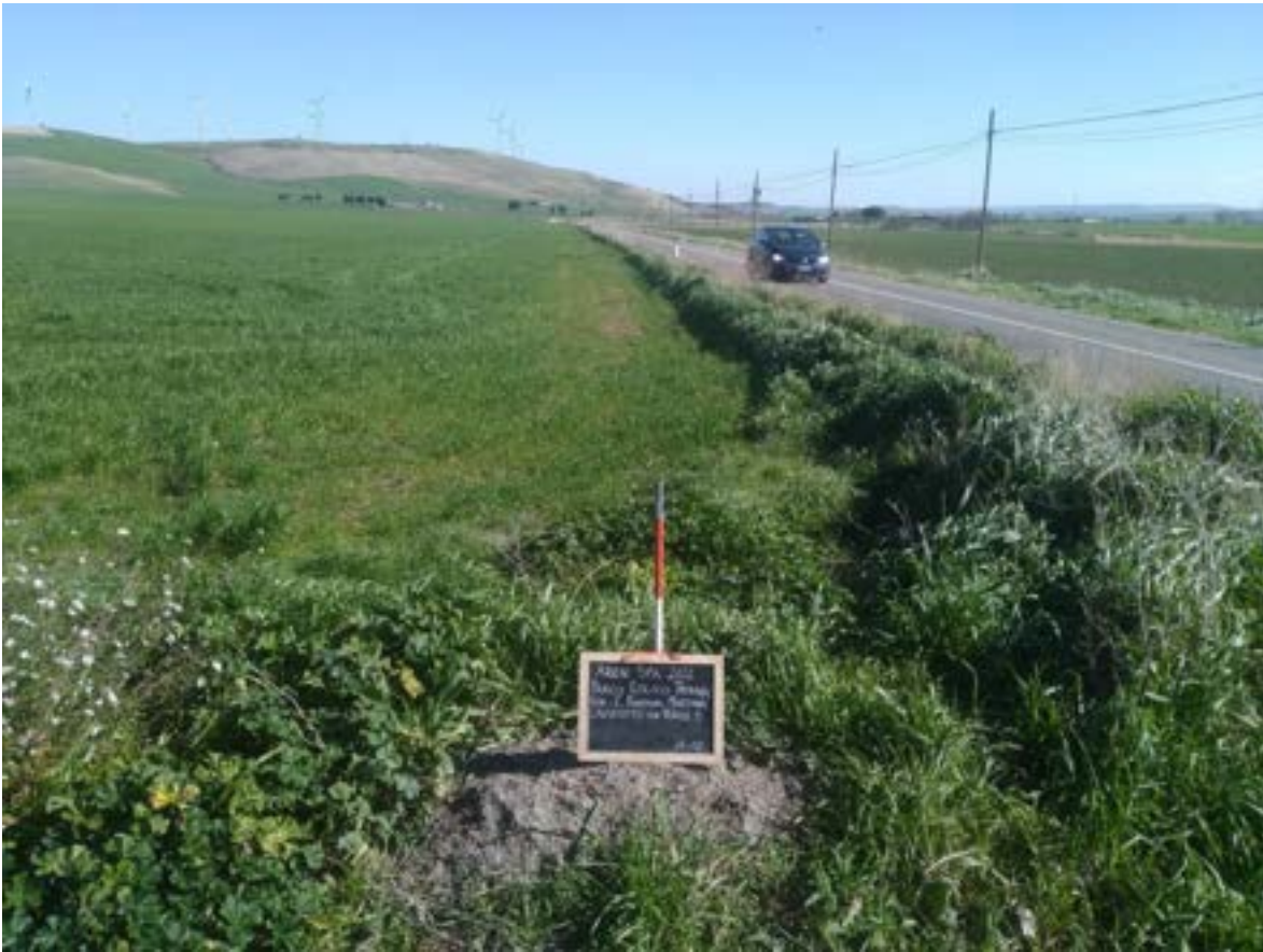
Figura 33. Cavidotto per torre 5
