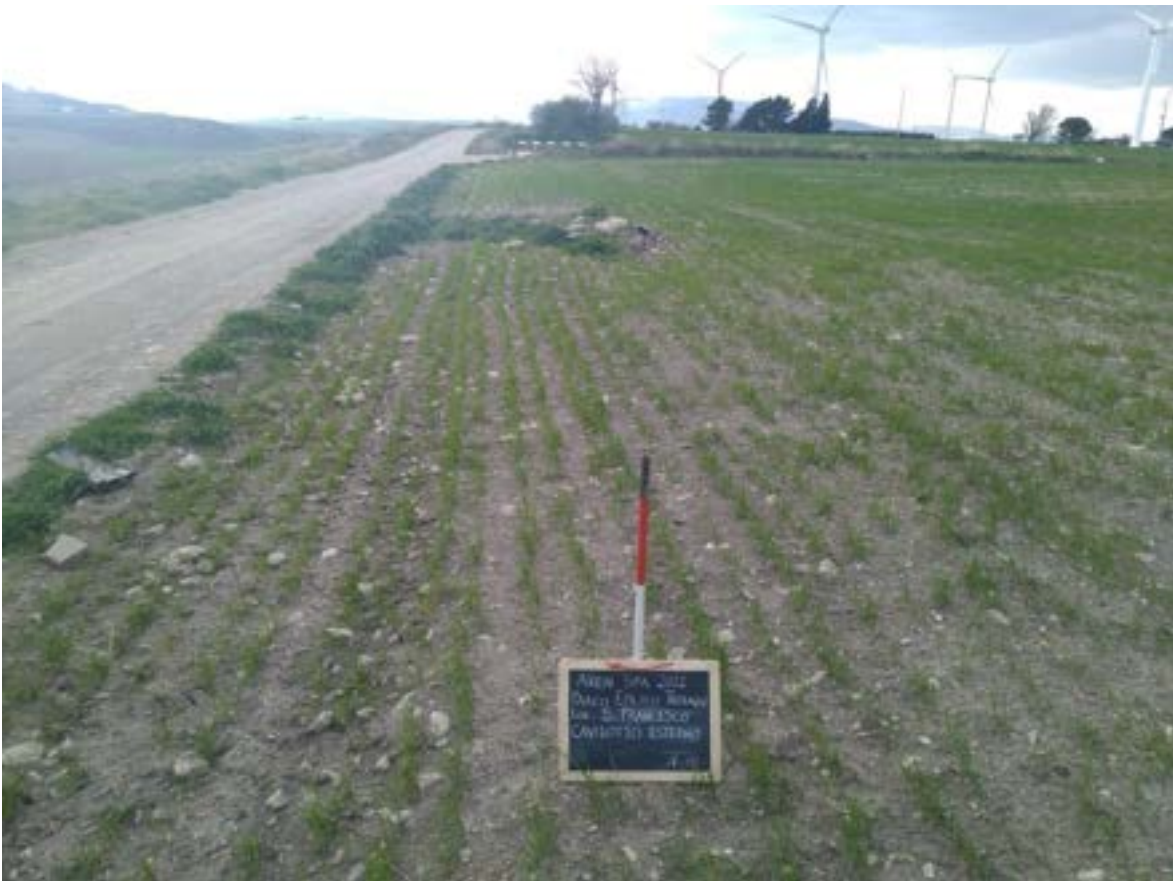
Figura 135. Cavidotto esterno I tratto
