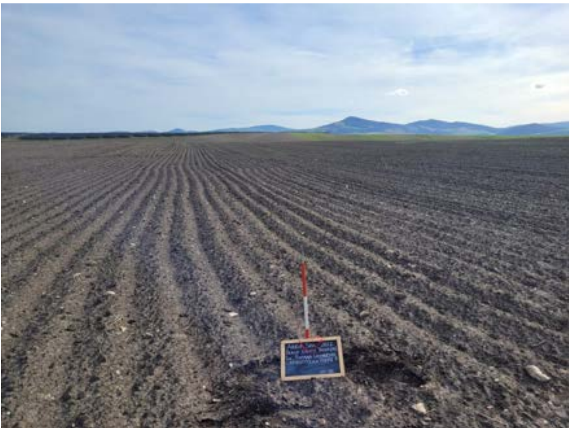
Figura 111. Cavidotto per torre 9
