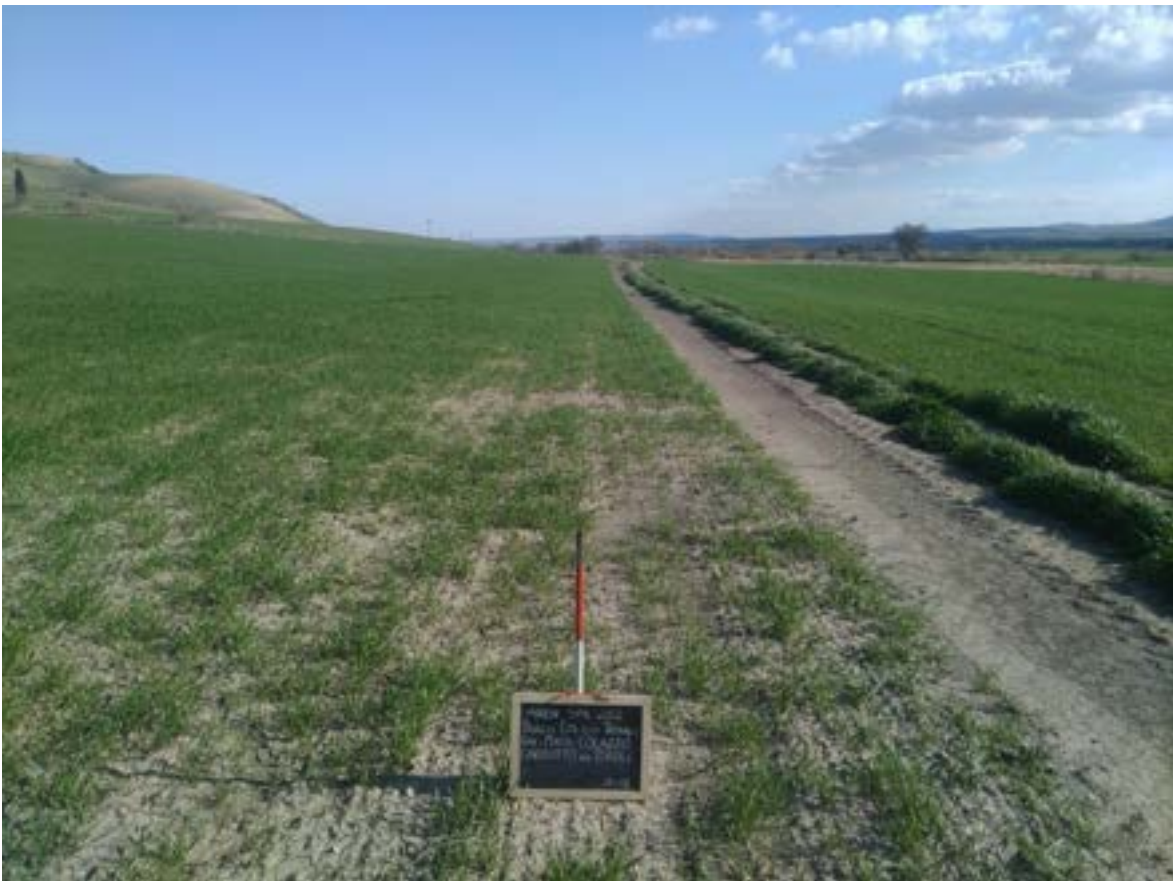
Figura 46. Cavidotto per torre 6
