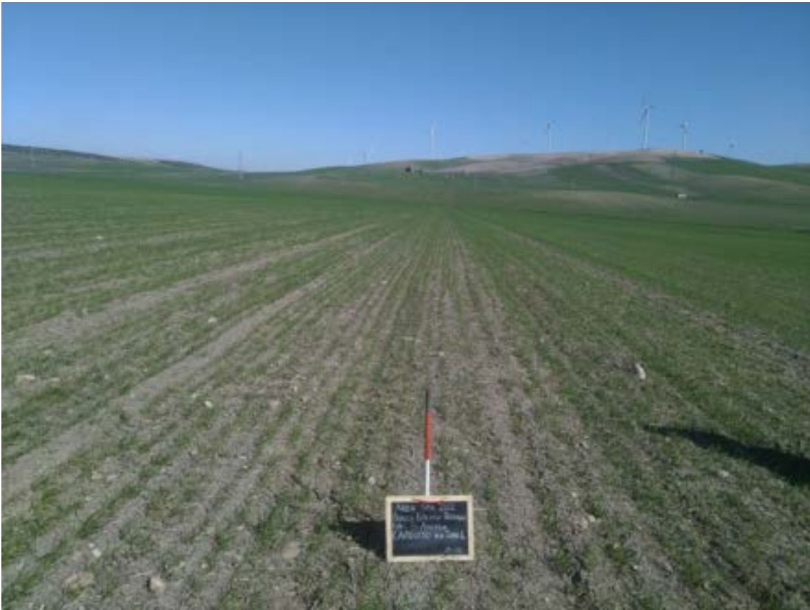
Figura 27. Cavidotto per torre 4
