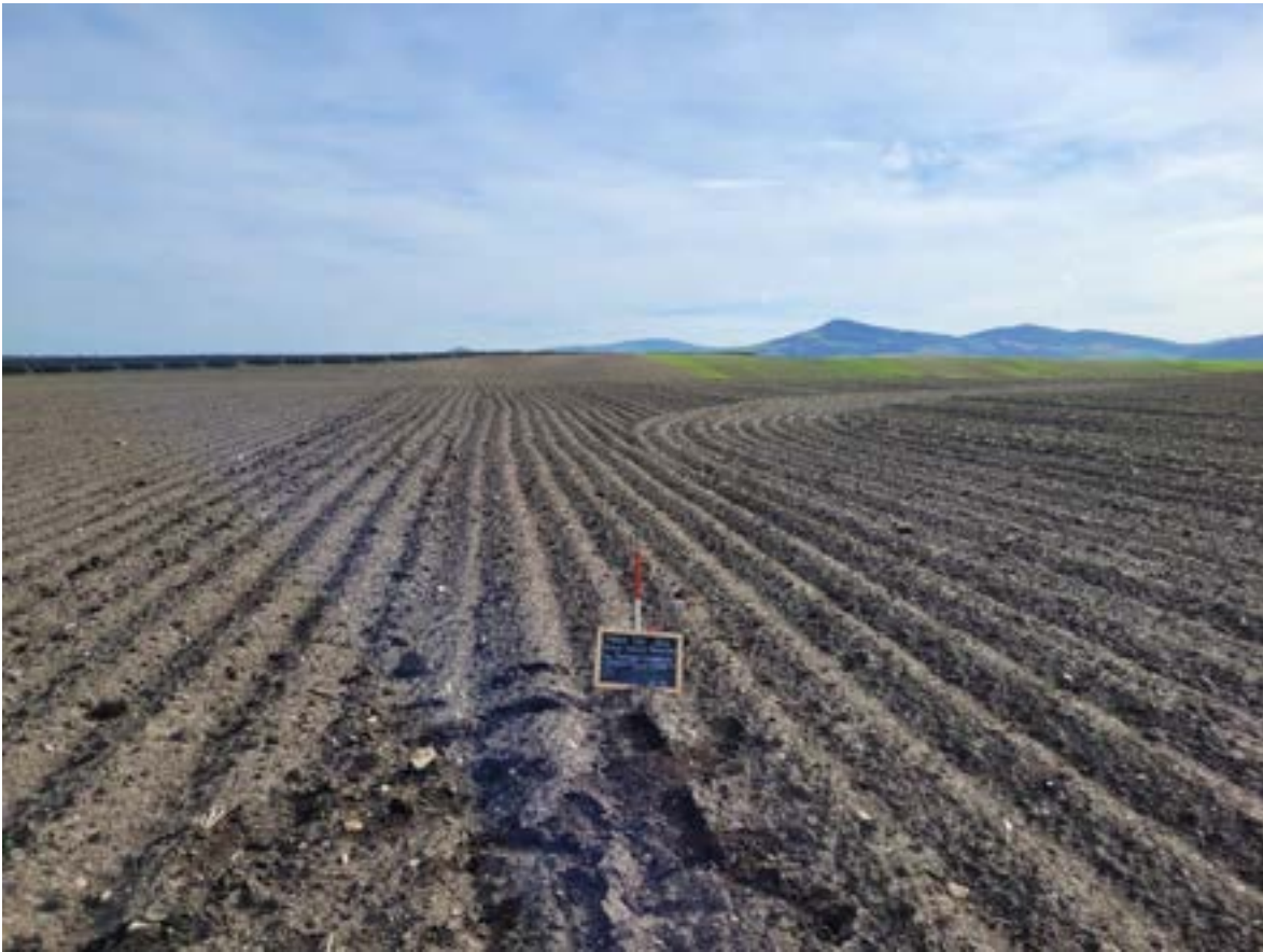
Figura 112. Cavidotto per torre 9
