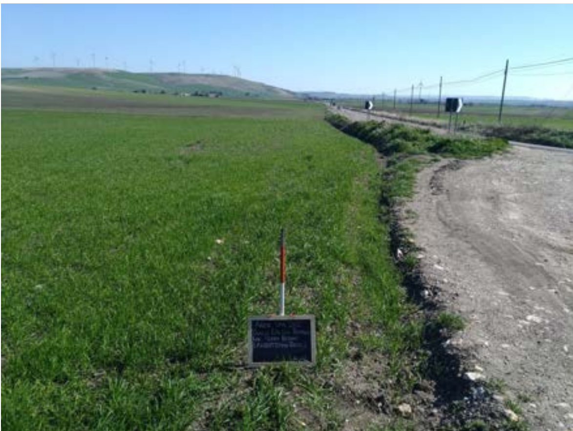
Figura 10. Cavidotto per torre 2
