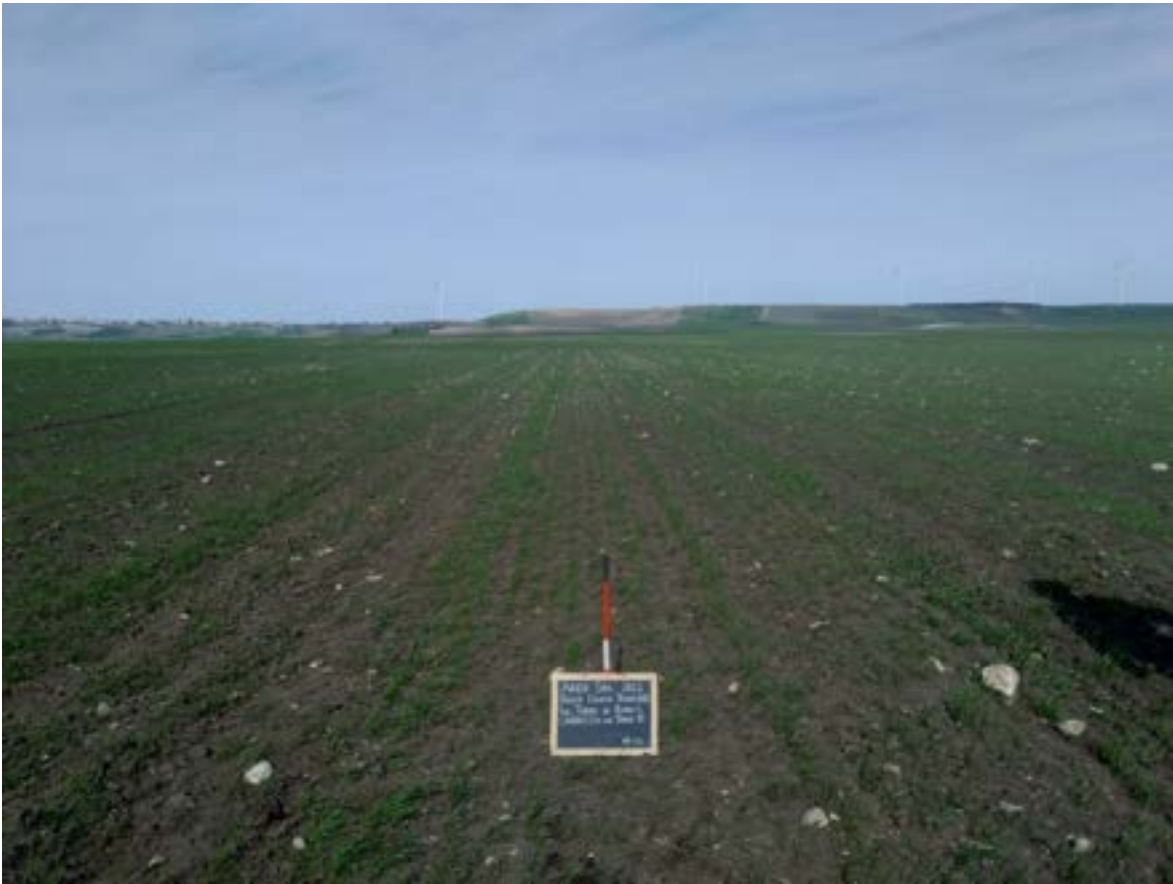
Figura 63. Cavidotto per torre 15
