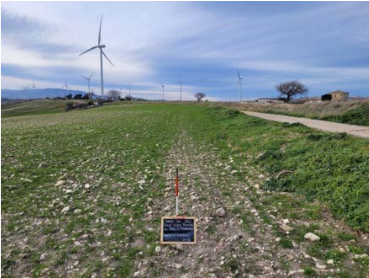
Figura 134. Cavidotto esterno I tratto
