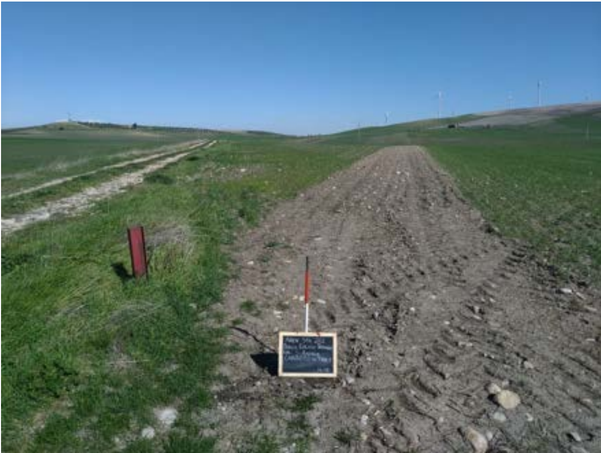
Figura 20. Cavidotto per torre 3
