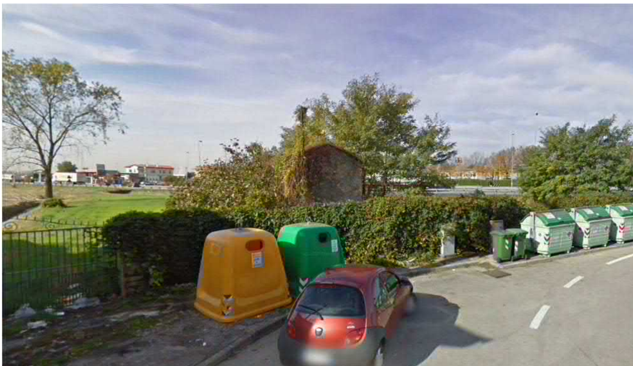
Figura 3 - RUDERE DA DEMOLIRE (FOTO DA STREET VIEW)
