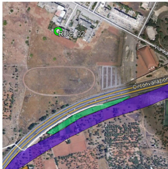
Ubicazione del punto di monitoraggio RUC02 rispetto alle aree di lavorazione sulla tangenziale S.S. n.16
