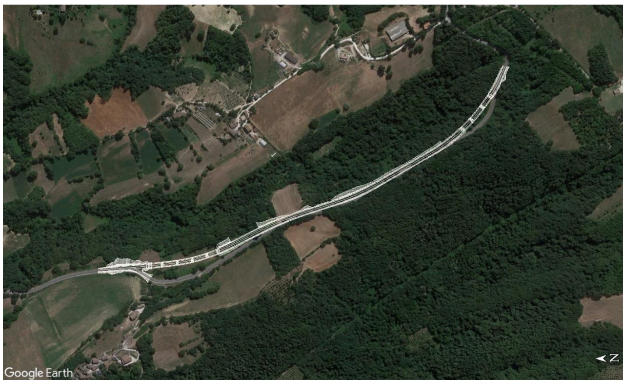
Figura 2-90 - Lotto 2 Stralcio 1 Lungo la S.S. N. 78 "Picena" - Sarnano – Amandola – secondo tratto Montane-Rustici in direzione abitato di Rustici per uno sviluppo di circa 2,20 km
