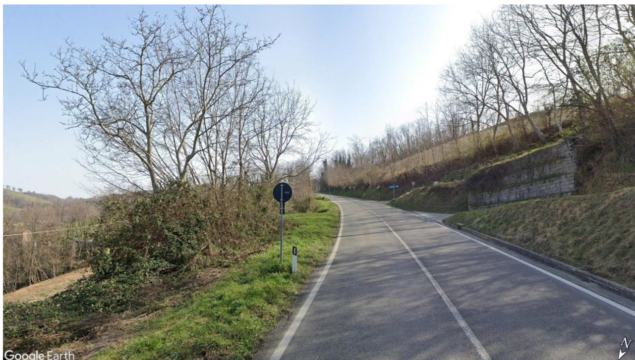
Figura 2-91 – Secondo tratto di intervento sulla SP237 stato attuale stradale in direzione sud verso Amandola
